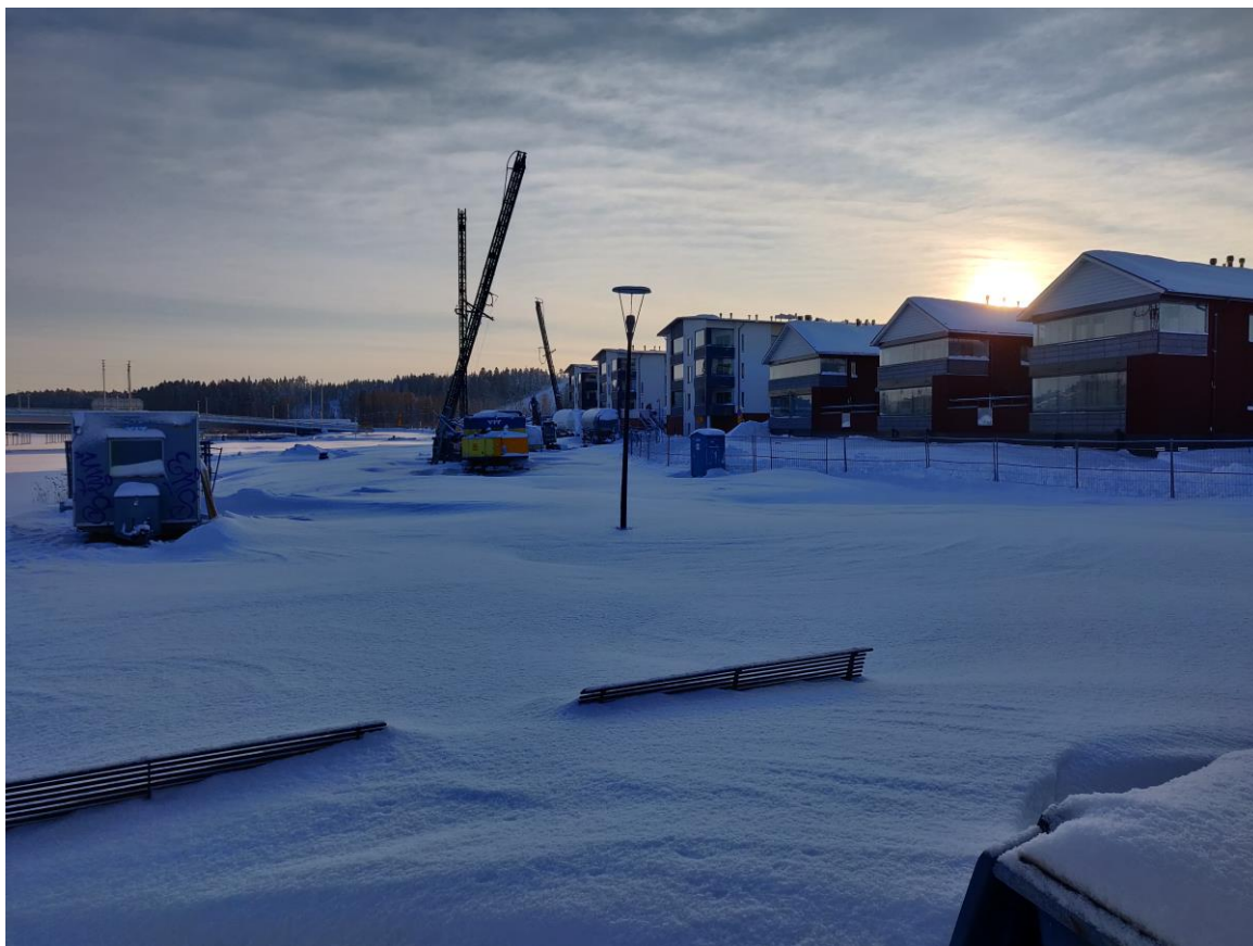
Kuva 15. Aleksinpuisto ja rakennustyömaa talvella. Topi Haapanen 2021.
