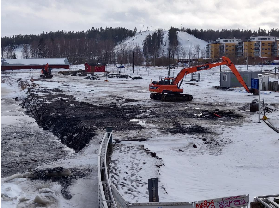
Kuva 20. Taidetehtaan rantapuiston pintamaiden poistoa. Topi Haapanen 2020.
