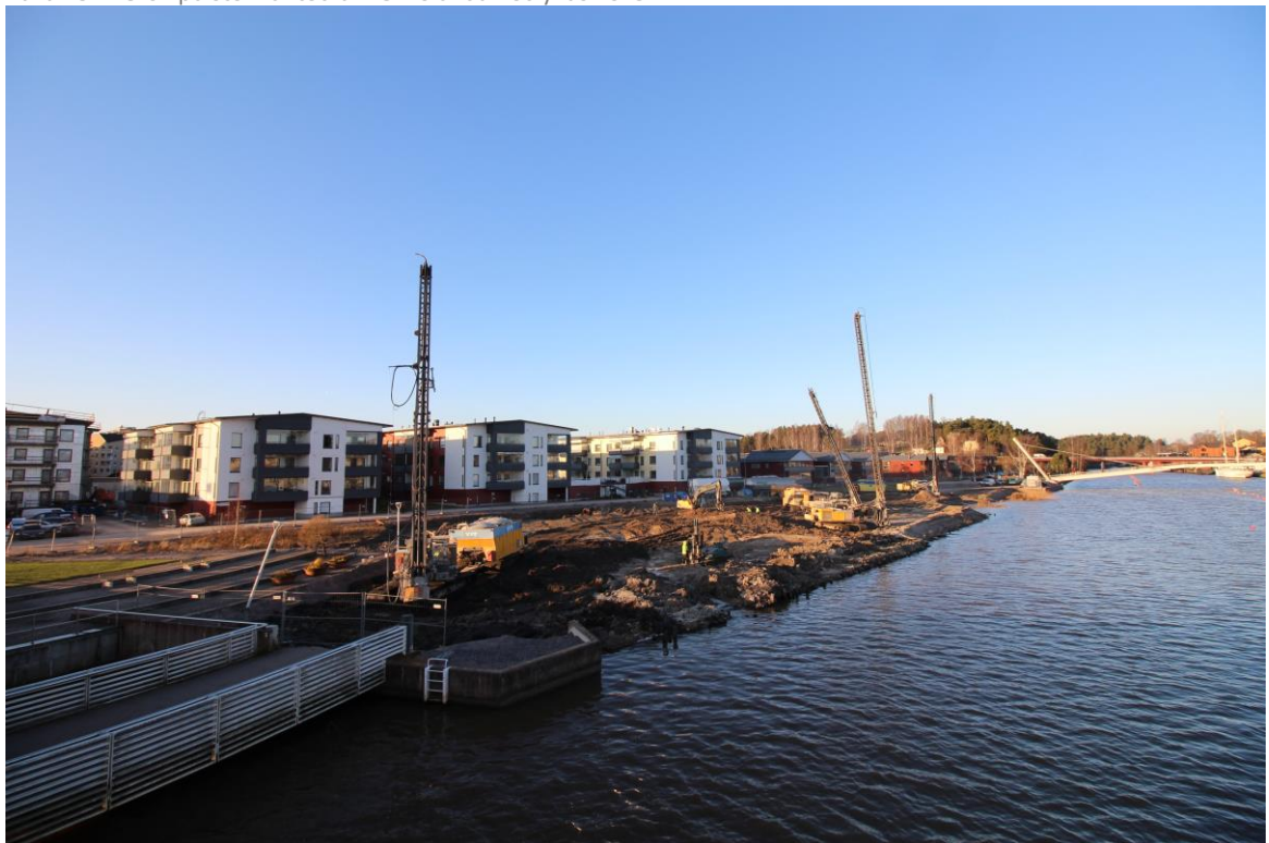
Kuva 14. Aleksinpuiston pohjatyöt. Topi Haapanen 2020.
