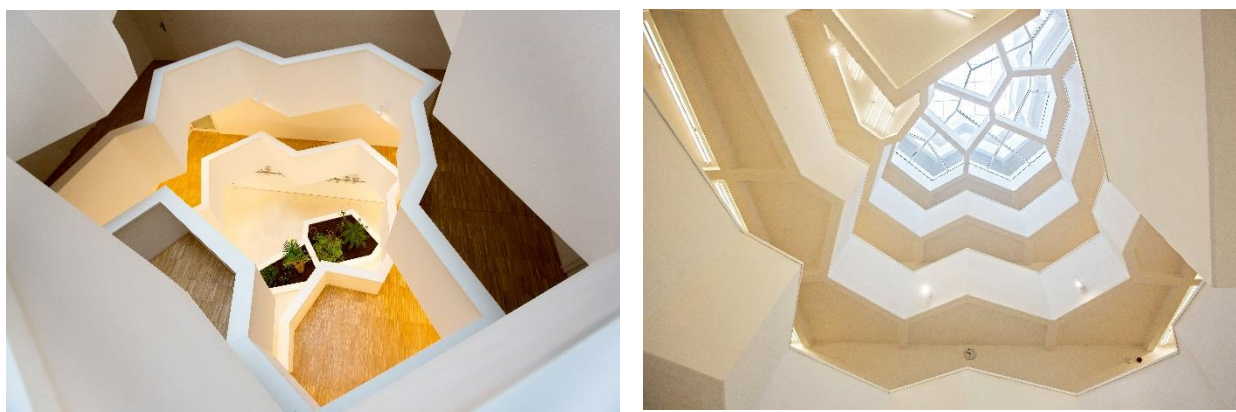
Obrázek 5 Moderní vzhled školy po rekonstrukci (průhled na několik pater budovy)
