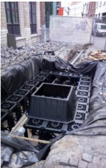
Figuur 6.11: Detail ondergrond boombunker Hallestraat (bron: stad Mechelen)
