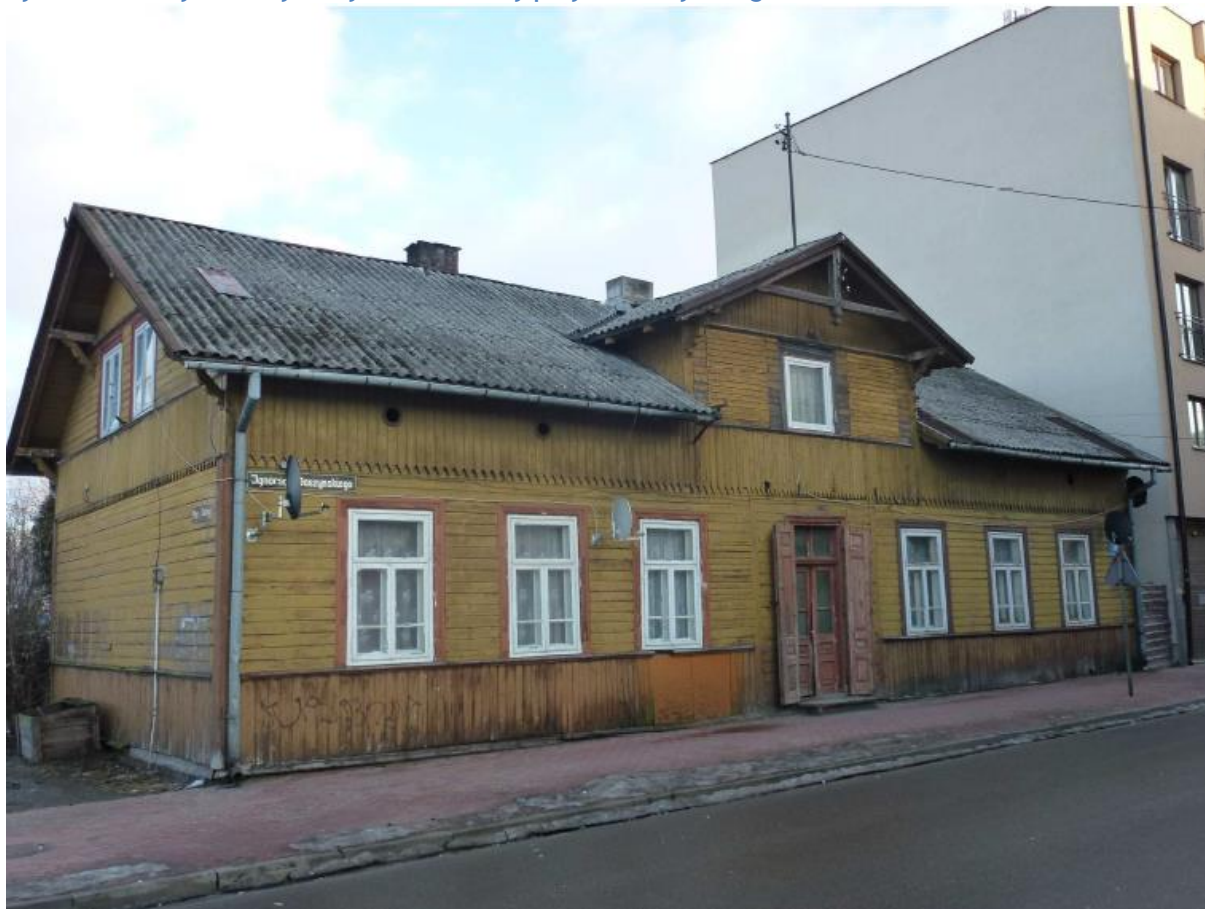
Rysunek 6. Budynek zabytkowy zlokalizowany przy ul. Daszyńskiego 18
