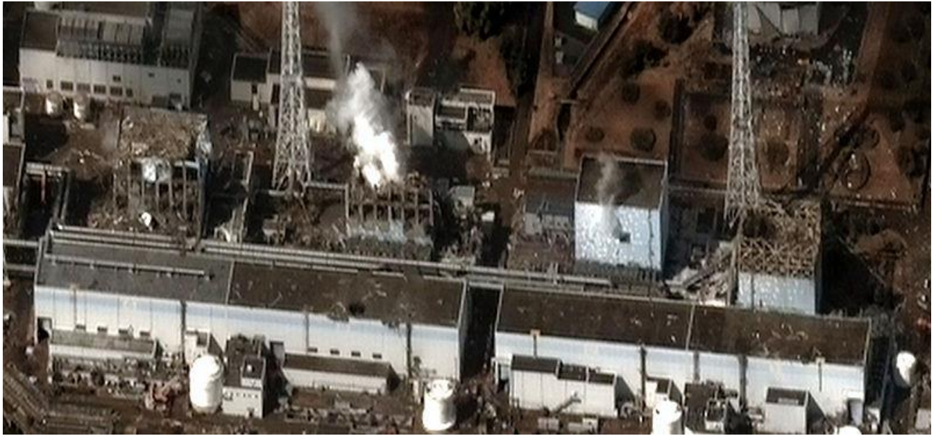
Figura 1. Reactoarele 1, 3 și 4 (de la dreapta la stânga) au fost cele mai avariate
