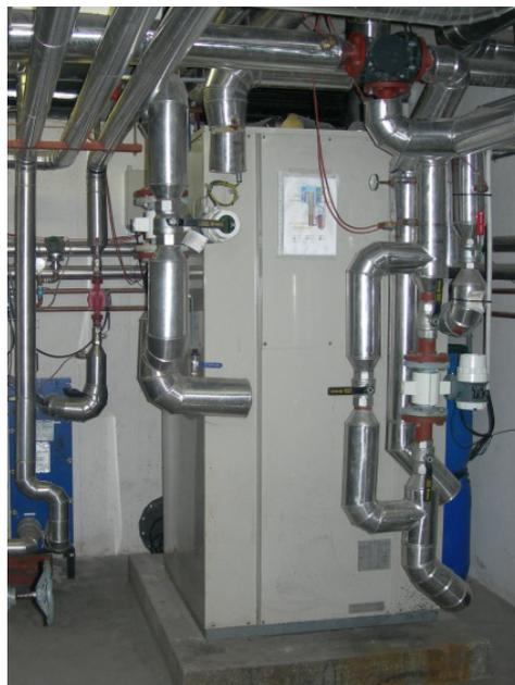
Figura 21: Máquina de absorção
