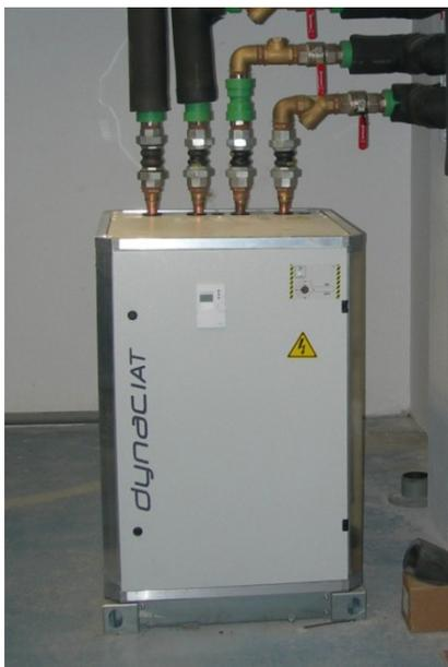
Figura 20: Bomba de calor geotérmica
