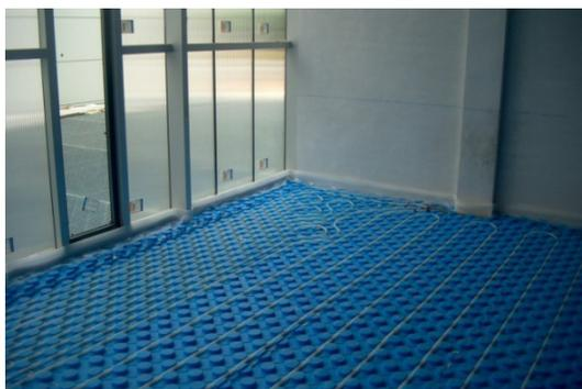
Figura 17: Montagem de piso radiante
