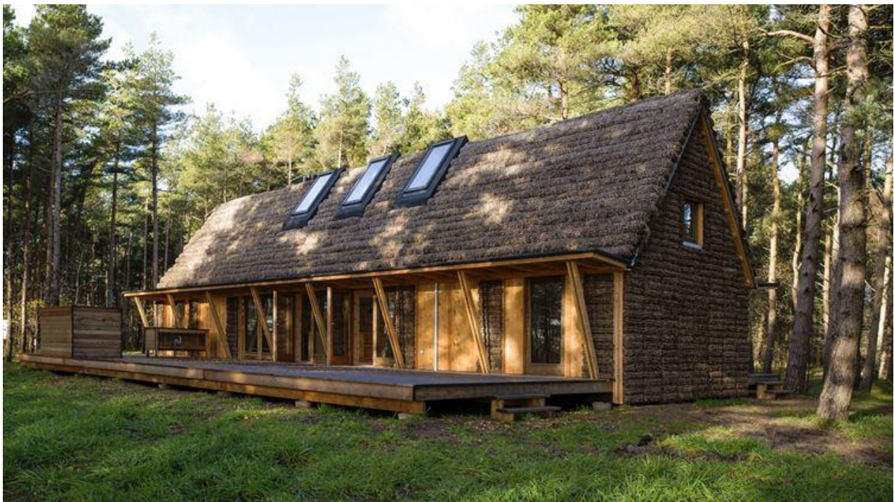
Figur 23 Moderne tanghus bygget på Læsø med støtte fra Realdania. I det moderne tanghus bliver ålegræs brugt på tre forskellige måder: som isolering, som indvendig polstret beklædning og som udvendig synlig beklædning. Ved brug af ålegræs bindes CO 2 , og substituering af traditionelle byggematerialer medfører ligeledes en væsentlig reduktion af byggeriets klimabelastning. (Fra Realdanias hjemmeside).
