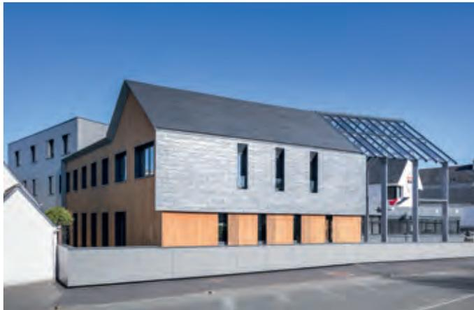
En 2015 Cupa Pizarras lanzou o seu sistema de fachada ventilada ecolóxico elaborado con lousa natural —Cupaclad—, fiel ao seu empeño en desenvolver innovadoras solucións que se adapten ás novas tendencias arquitectónicas. O uso de lousa tectónica de alta durabilidade, os novos sistemas de fixación e a eficiencia da fachada ventilada, converten a Cupaclad nunha alternativa competitiva e sustentable para o revestimento de calquera tipo de fachada.
