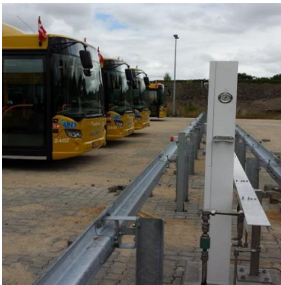
Figur 4: Gastankstation med slow-fill i Holstebro.
