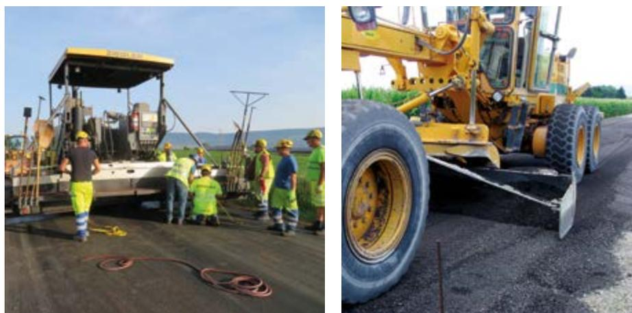
**Figure 3** / ORRAP Suisse & France - Mise en œuvre avec un finisseur/une niveleuse
