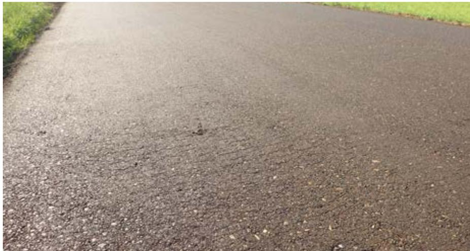
**Figure 5** / ORRAP Suisse - Des vibrations peuvent générer des fissures
