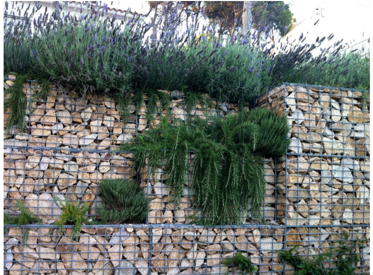
Vedação feita com gabiões e vegetação xerofítica. Fonte : https://www.gaviones.es/projectes/mur-de-gabions-vegetal/
