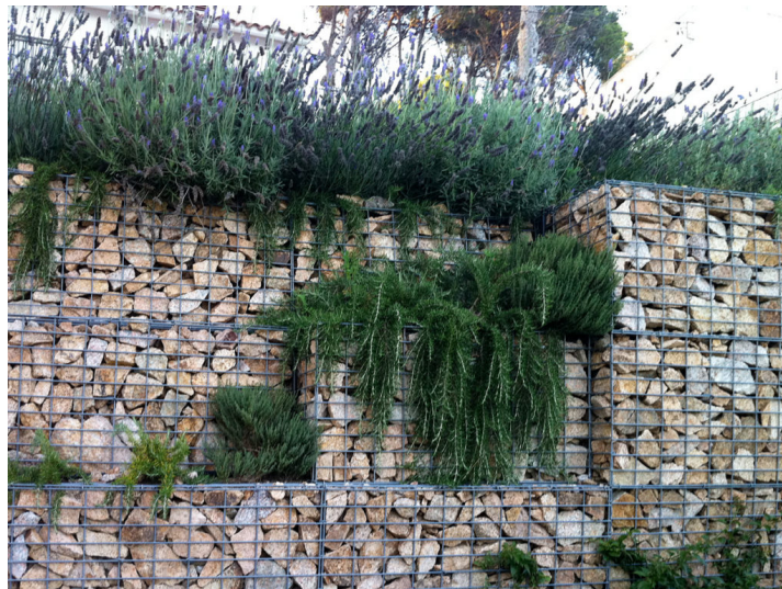
Cerramiento realizado a base de gaviones y vegetación xerófila. Fuente: https://www.gaviones.es/proyectos/mur-de-gabions-vegetal/
