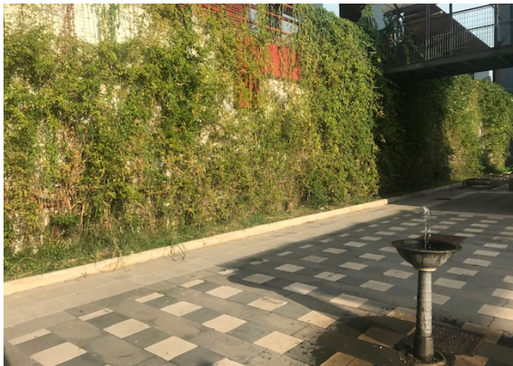
Vegetación trepadora, sobre soporte metálico, cubriendo un cerramiento vertical en el campus de la Universidad de Salerno, Italia (Campus Fisciano). Fuente: la autora
