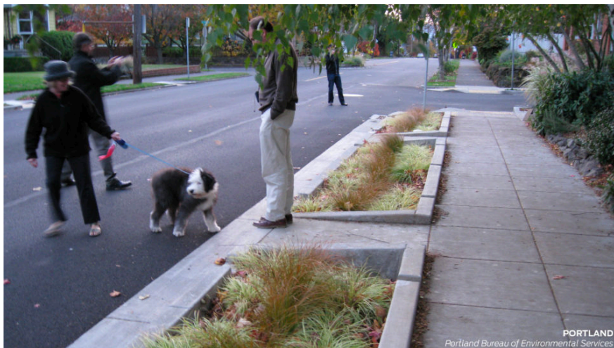
Franja filtrante en Portland, Oregón, Estados Unidos. Fuente: https://nacto.org/publication/urban-street-stormwater-guide/stormwater-elements/
