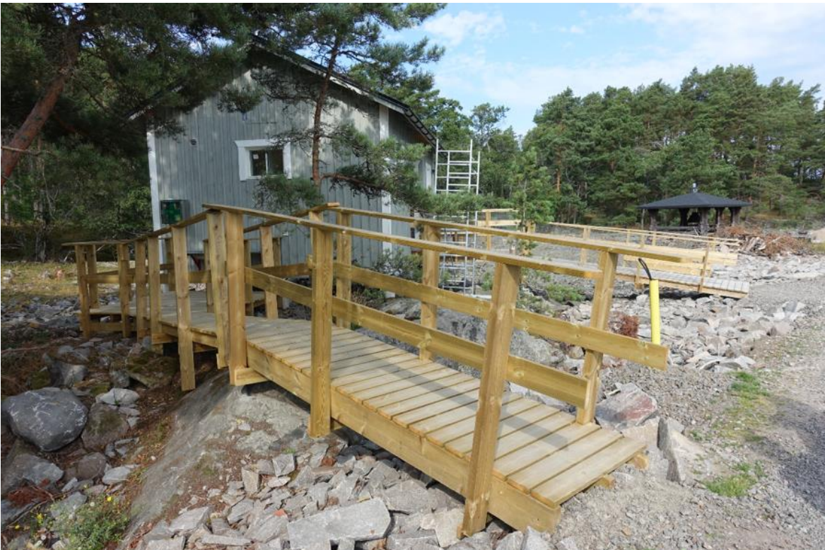
The new service building on Katanpää. Photo: Metsähallitus / Sanna-Kaisa Juvonen.
