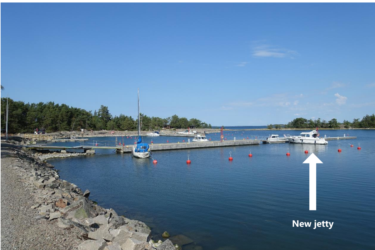
The new jetty on Katanpää. Photo: Metsähallitus / Sanna-Kaisa Juvonen.
