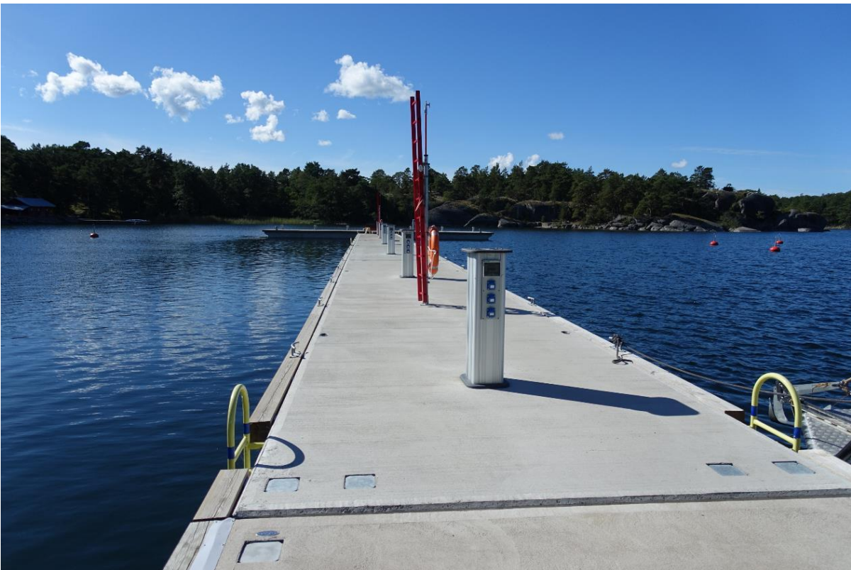
The new jetty on Bodö. Photo: Metsähallitus / Sanna-Kaisa Juvonen.
