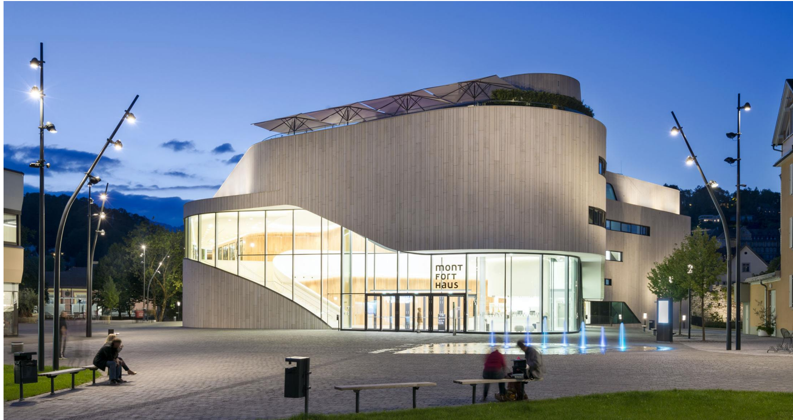
LDE Belzner Holmes_Montforthaus Feldkirch Aussenbeleuchtung_Fotograf Kolm
