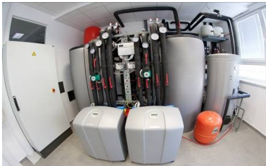
Figura 6.6: La combinazione di un serbatoio di stoccaggio dell'acqua calda e fredda, caldaia e pompa di calore reversibile nella sottocentrale termica.
