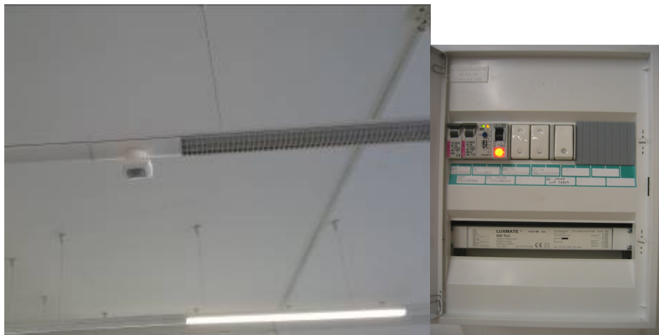
Figura 6.8: Sensore di presenza legato all'impianto di illuminazione; centralina di controllo dell'illuminazione a 4 scenari
