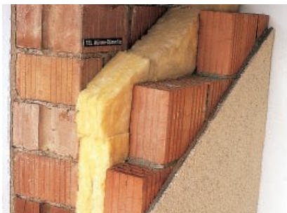
Figura 6.2: Esempio di isolamento termico
