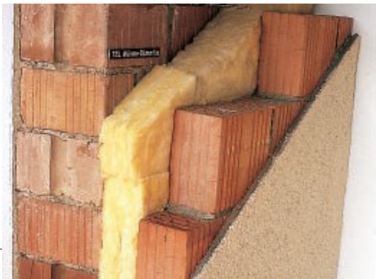
Esempio di isolamento termico
