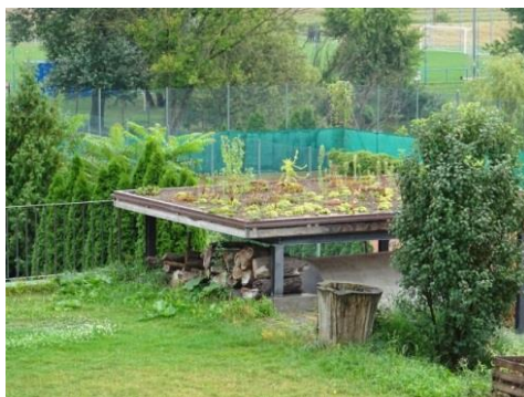
Fig. 8 Green roof (Photo: B. Vojvodiková)
