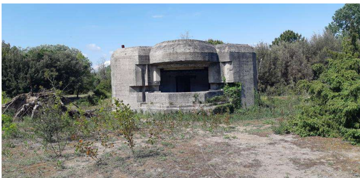
Figura 3-23 Resti di bunker della Seconda guerra mondiale, con area in cui viene effettuata la gestione della vegetazione.
