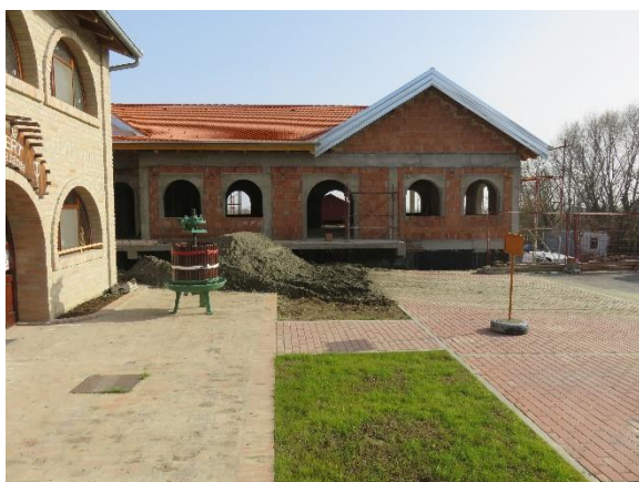
dvorište i objekt u izgradnji
