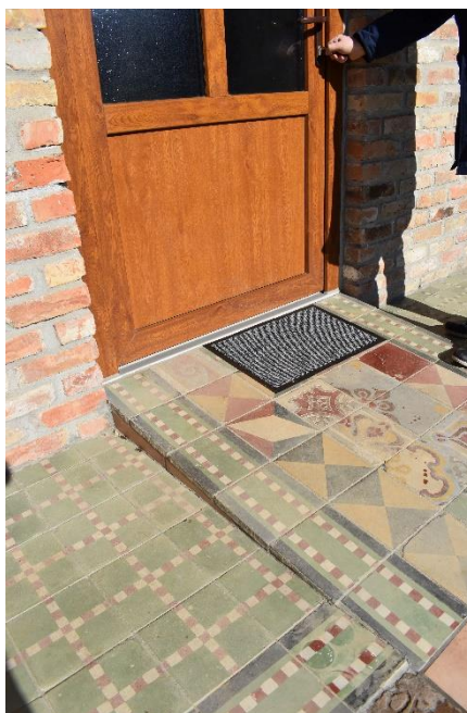
pristupna kosina dograđene kuće
