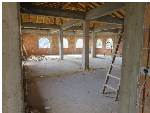
unutrašnjost objekta u izgradnji
