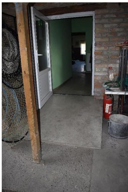
pristupna kosina dodatnog ulaza
