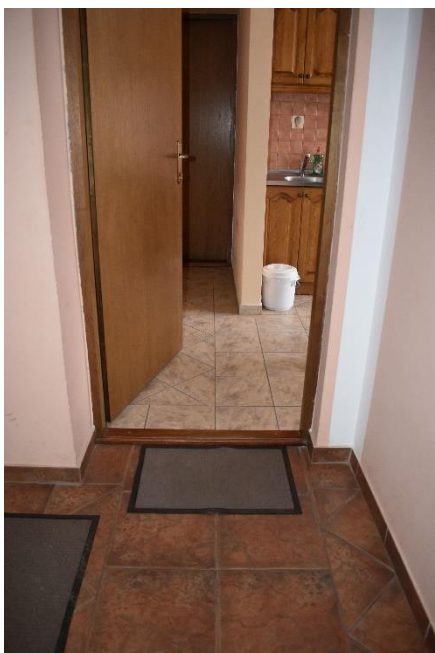
prilaz kuhinji u prizemlju
