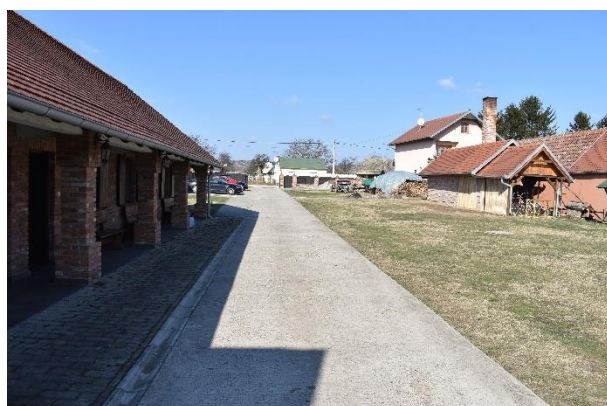
betonski i cigleni prilaz
