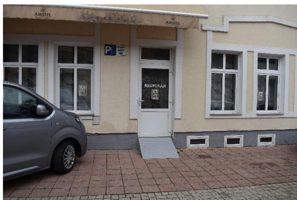
strma pristupna kosina pred restoranom
