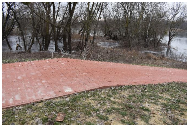
strmi spuštjeni prilaz pristaništu čamaca
