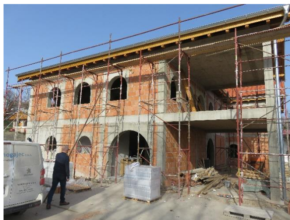
objekt u izgradnji
