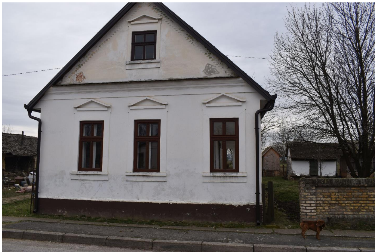
cestovni prilaz i pročelje
