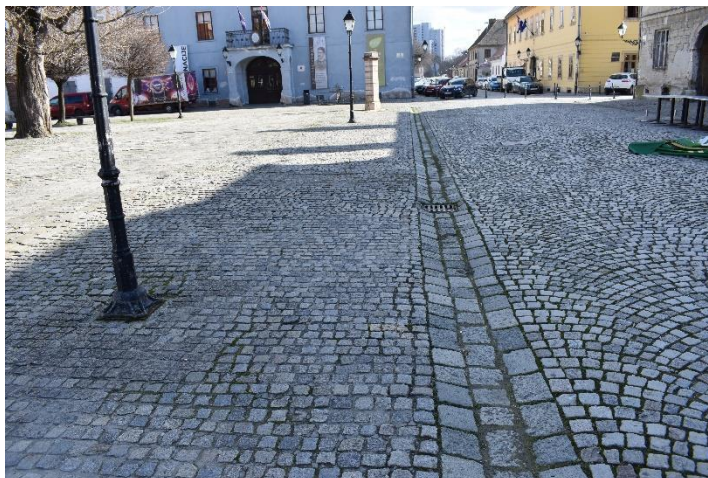
užljebljenja odvoda
