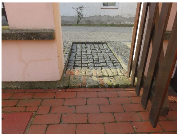
cestovni prilaz i dvorišni ulaz
