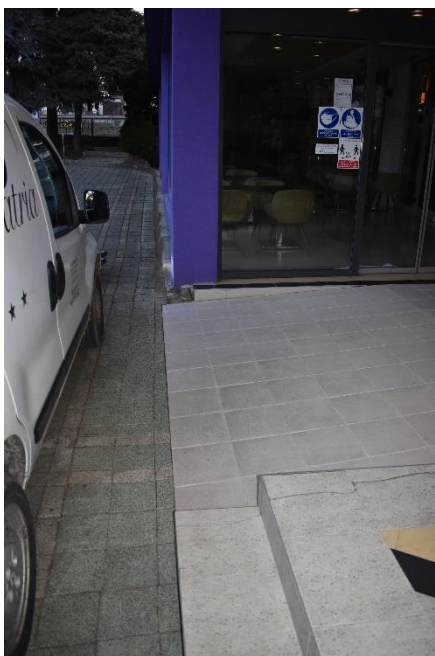
zapriječena pristupna kosina
