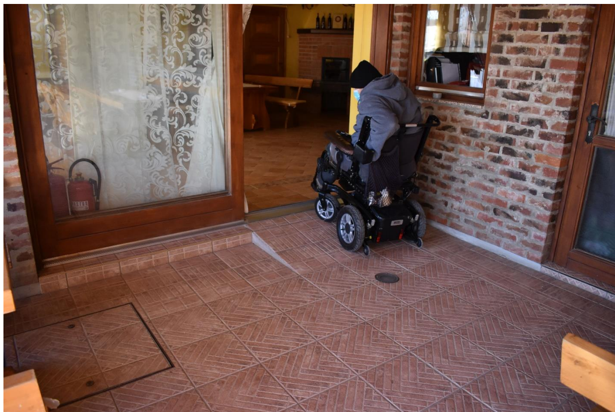
pristupna kosina i prag pred ulazom
