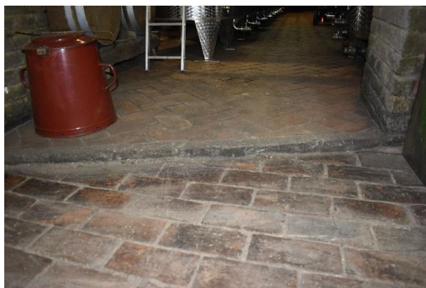
spušteni prilaz i prag pred ulazom
