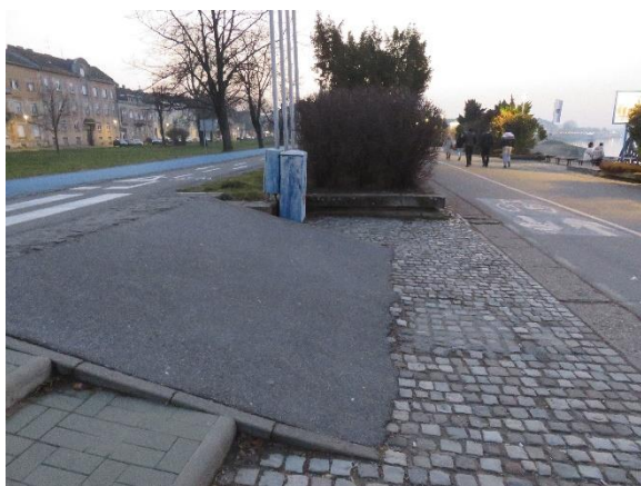
južna pristupna kosina 2
