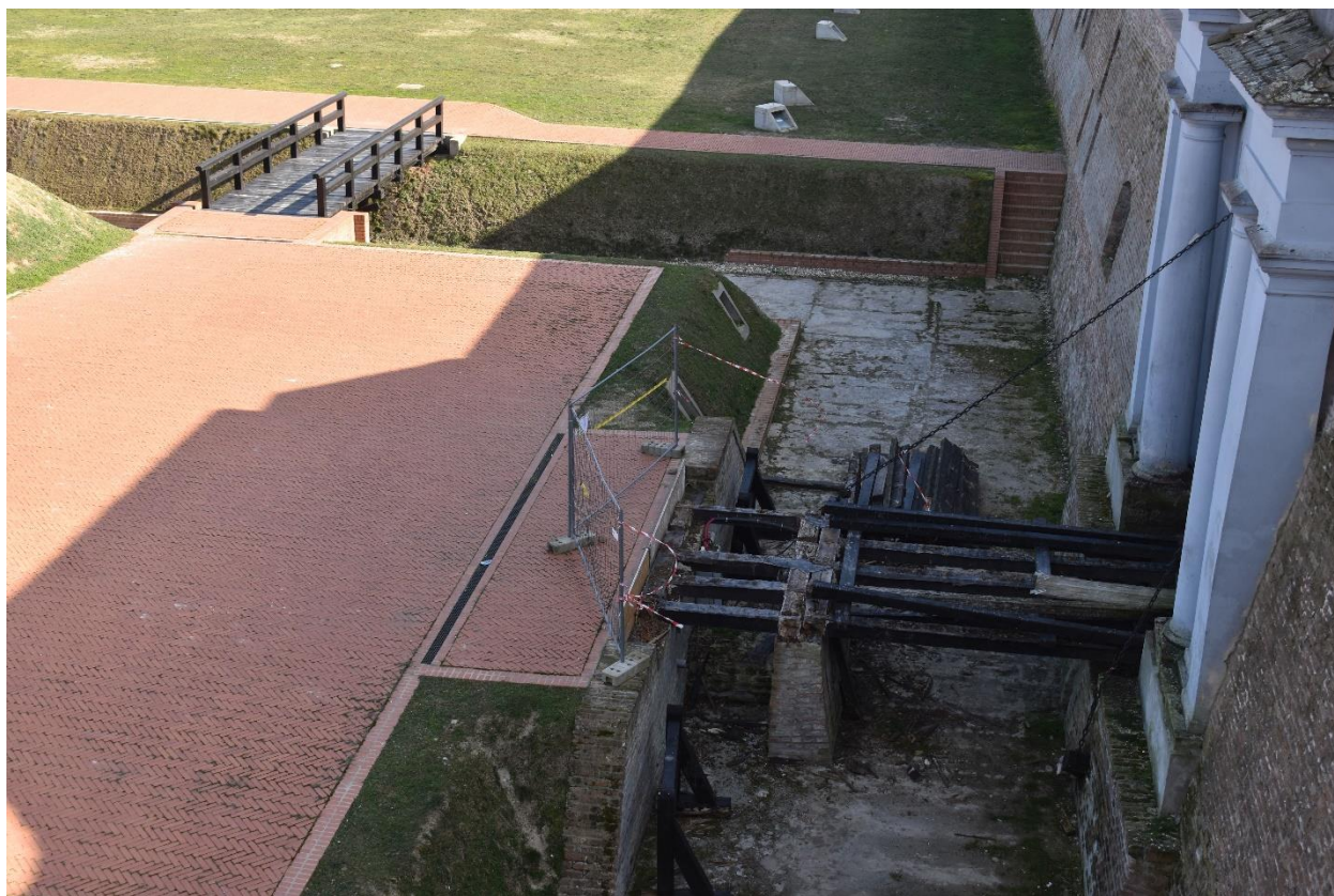
radovi na ulaznom mostu
