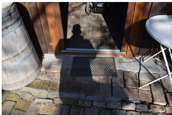
prag pred glavnim ulazom restorana
