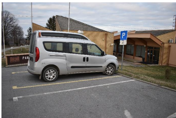
parkiralište i početak kompleksa
