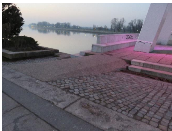
južna pristupna kosina 3
