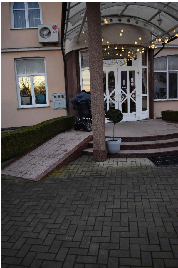
prilaz i lijeva pristupna kosina
