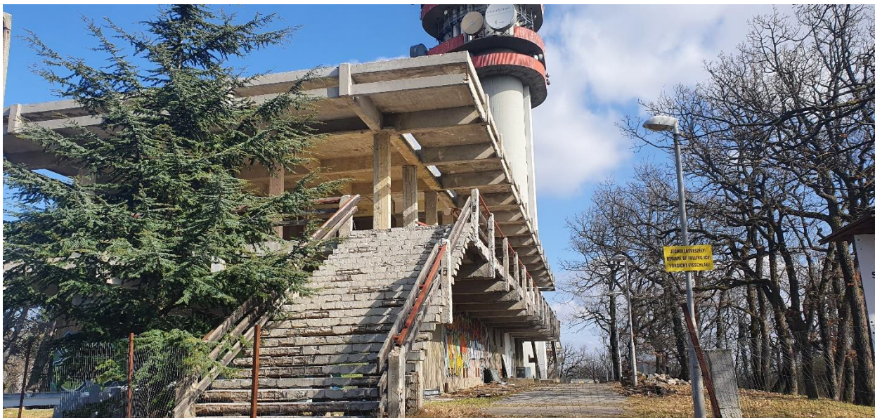
A TV-torony és a felújítás alatt lévő étterem épület
