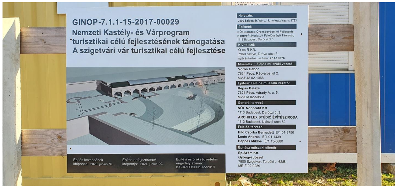
A felújítás alapadatait tartalmazó tájékoztató tábla
