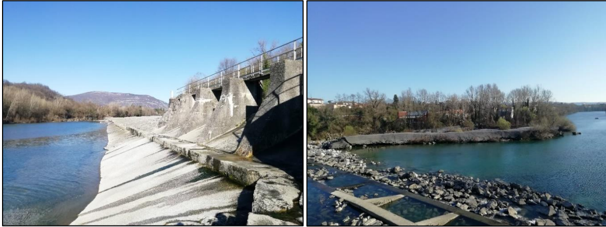
Figura 7. A sinistra la vista della traversa parco Piuma in sinistra idrografica. A destra la vista della soglia di Straccis verso valle.
