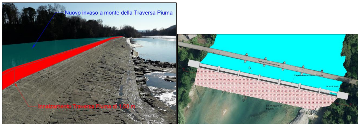
Figura 8. A sinistra lo scenario che si verrebbe a creare con l'innalzamento della traversa parco Piuma. A destra la planimetria della ipotizzata traversa di Straccis.
