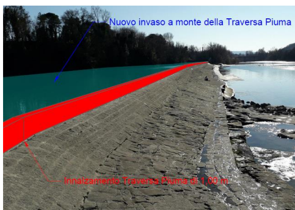
Podoba 8. Na levi scenarij, ki bi nastal, če bi dvignili prečno pregrado pri pevskem parku. Na desni načrt predvidene pregrade v Stražcah.
