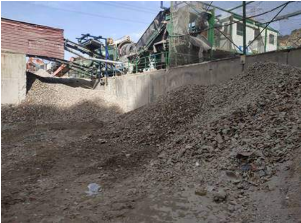
Figura 55. Instalación de la planta de reciclaje y cabina de triaje
