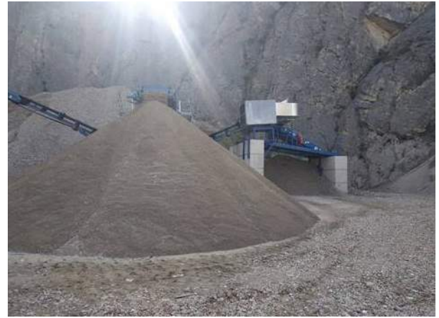
Figura 48. Acopio del material fino tras un nuevo proceso de limpieza Fuente: GAN-NIK
