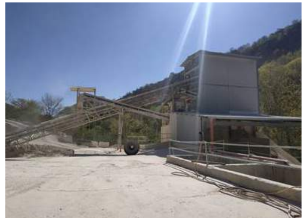
Figura 84. Cinta transportadora y zona donde se produce el cribado final
