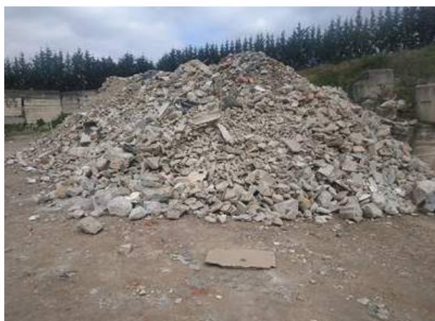
Figura 88. Acopio de escombros a tratar
