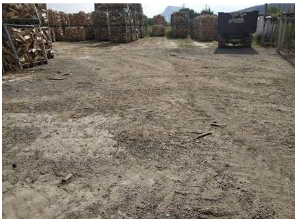
Figura 105. Adecuación del terreno de una nave industrial de madera con árido reciclado Fuente: GAN-NIK
