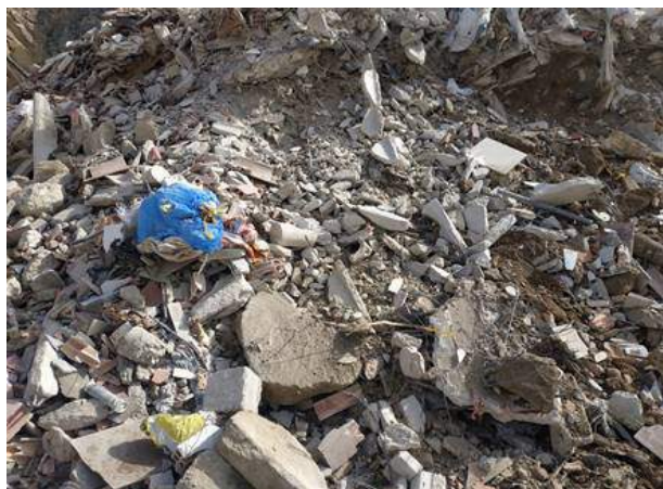
Figura 43. Acopio del escombro recibido Fuente: GAN-NIK
