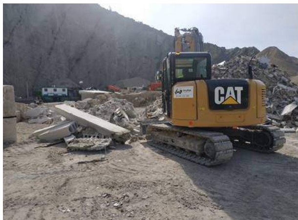
Figura 41. Proceso de tratamiento mediante cizalla de las piezas prefabricadas
