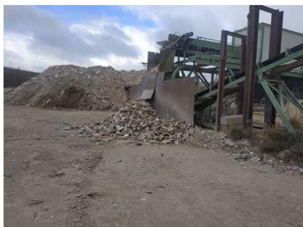
Figura 70. Instalación para la separación de impropios y el machaqueo del residuo Fuente: GAN-NIK
