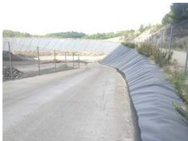
Figura 109. Acceso al vertedero
