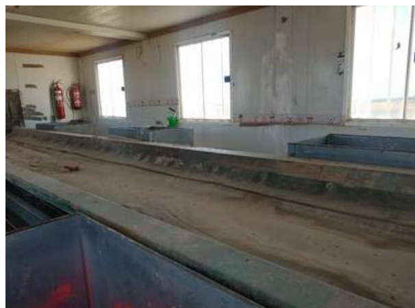
Figura 117. Interior de la cabina de triaje Fuente: GAN-NIK
