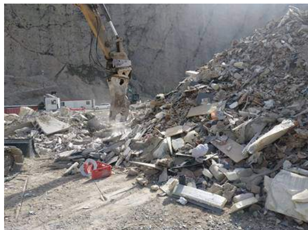
Figura 42. Cizalla cortando las piezas de prefabricado
