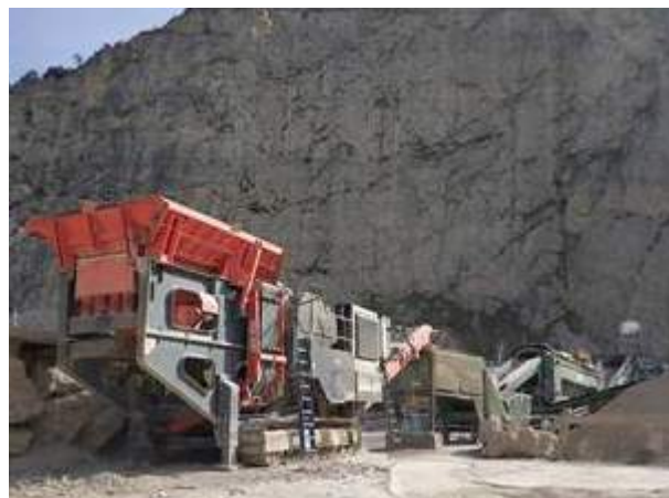
Figura 44. Instalación del proceso de pretratamiento Fuente: GAN-NIK
