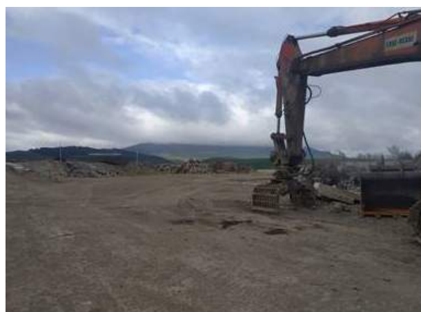
Figura 69. Cizalla para separar las armaduras metálicas del hormigón Fuente: GAN-NIK
