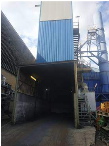
Figura 106. Silo donde se almacenan las arenas residuales distribuidas en tres tolvas
