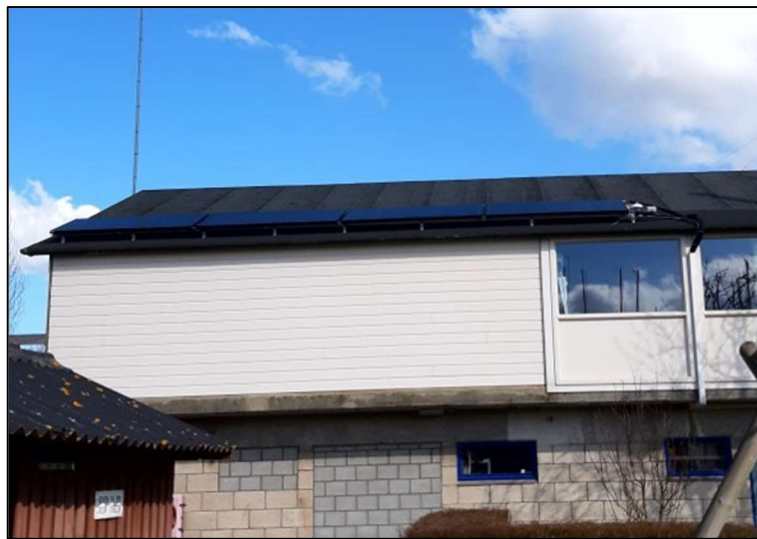
Figure 4.1 PVT-collectors placed at WSV Haringvliet (Hellevoetsluis), (Romijn, 2021)
