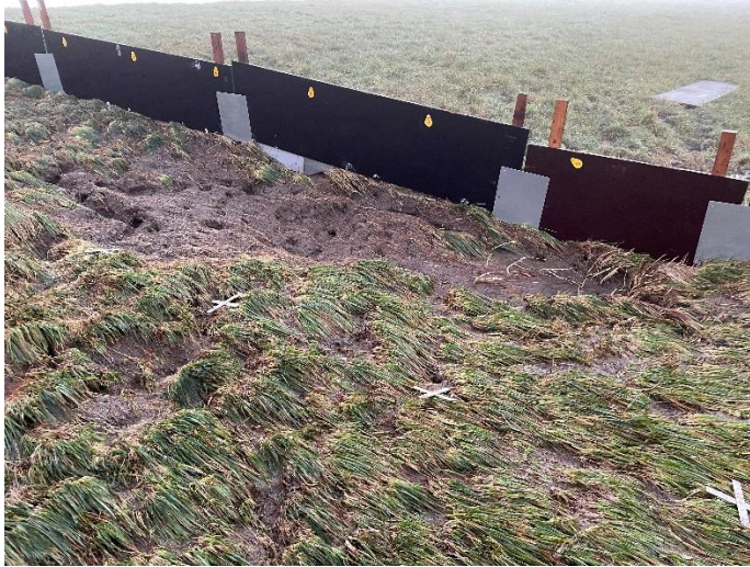
Figuur 4: De schotten worden met de kopse kanten tegen elkaar en verbonden met RVS platen (teststrook 1 binnen dijkvak VI)
