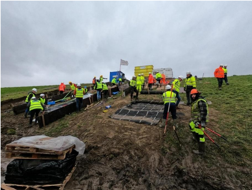
Figuur 46: Impressie reparatie schades voor Levee Challenge
