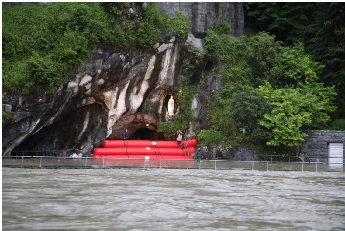
Fig. assemblage de boudins anti-inondation à l'entrée de la Grotte de Massabielle (Crédit photo : Sanctuaire de Lourdes/Vincent)
