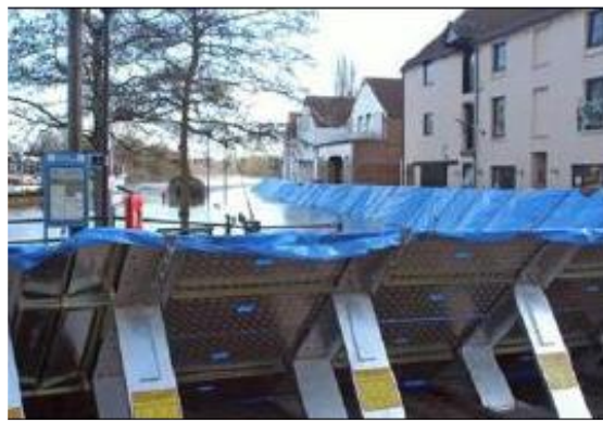
Fig. principe de fonctionnement d'un ouvrage dièdre (source : Cuirassier), exemples de défenses mobiles (Portadam, Geodesign)
