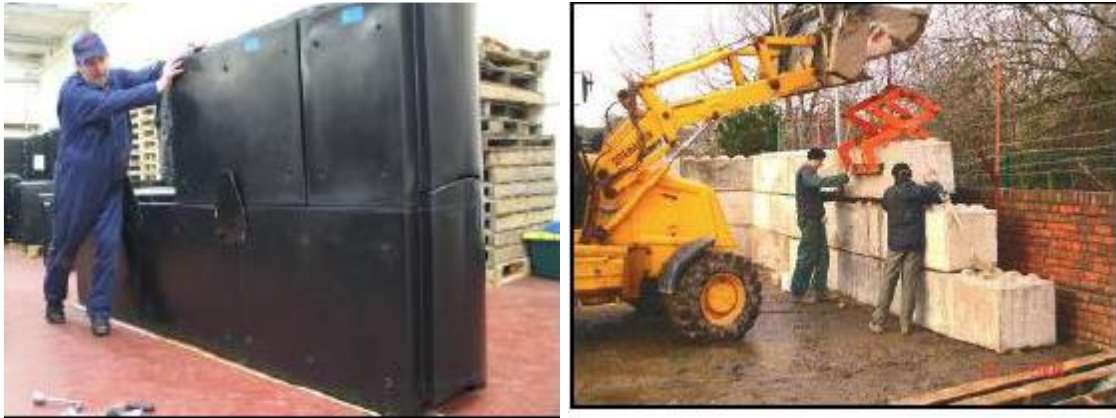
Fig. défenses par blocs bétons assemblés (Yewstop) et composite (MRP)
