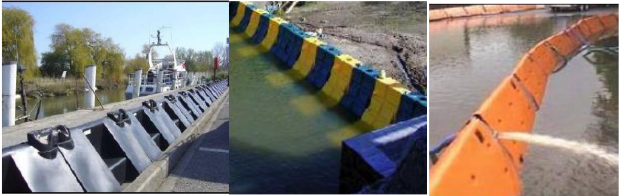
Fig. structures poids rigides profilées (FloodStop, Aqua-Levee , AquaBarrier)
