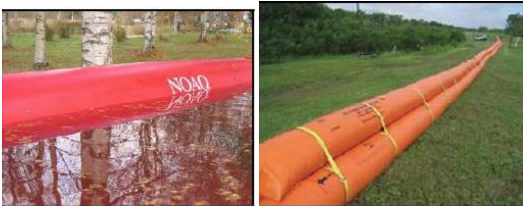
Fig. barrières par boudins remplis (NOAQ, Tigerdam)
