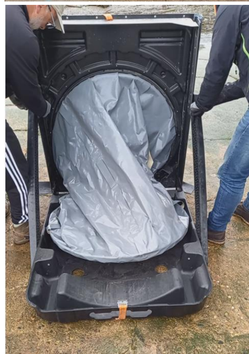
Cuirassier, pré-positionnement et déploiement, mise en place des raccords souples et des butées (Inundatio – Cerema - Cuirassier)
