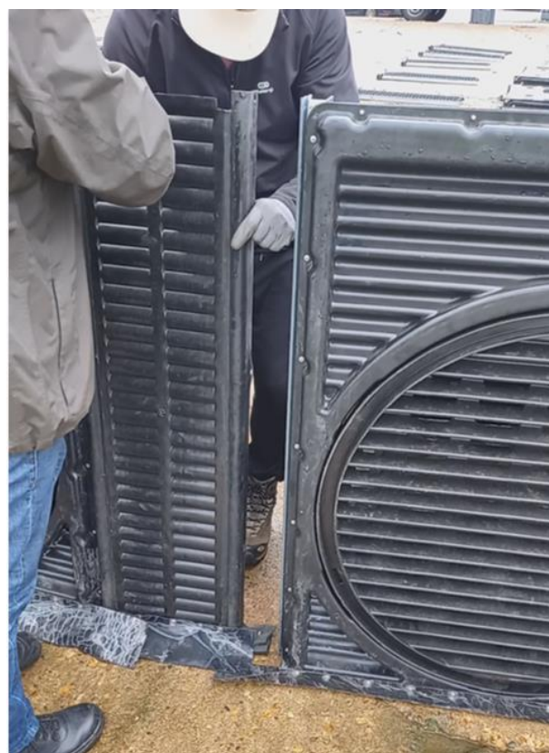
Cuirassier, pré-positionnement et déploiement, mise en place des raccords souples et des butées (Inundatio – Cerema - Cuirassier)
