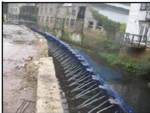
Fig. principe de fonctionnement d'un ouvrage dièdre (source : Cuirassier), exemples de défenses mobiles (Portadam, Geodesign)
