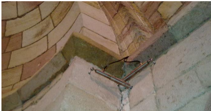
Figura 5. Fisurómetros instalados en la iglesia de Villanueva de la Torre (Palencia).
