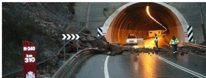
**Figura 12. Fotografías que muestran la afección por desprendimientos de roca en el entorno de la urbanización Cotobro (Túnel Punta de la Mona). En la imagen izquierda, se aprecia una labor de reparación de la ladera y retirada de bloques. En la imagen derecha, se aprecia un desprendimiento que rompió la malla de contención del talud y obstaculizó la Carretera Nacional N-340.**
