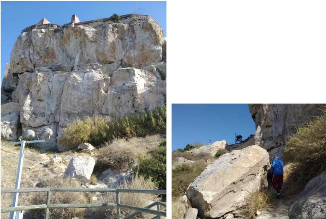
**Figura 13. Fotografías del escarpe del peñón del castillo de Salobreña. Se aprecian varios bloques caídos que han obstaculizado el sendero litoral de acceso**
