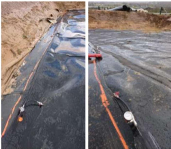
Mise en pression des doubles soudures
