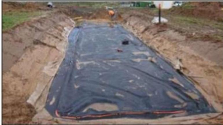
Reprise du Dispositif d'étanchéité du forage B2 au droit du casier 2 le 21 janvier 2020
