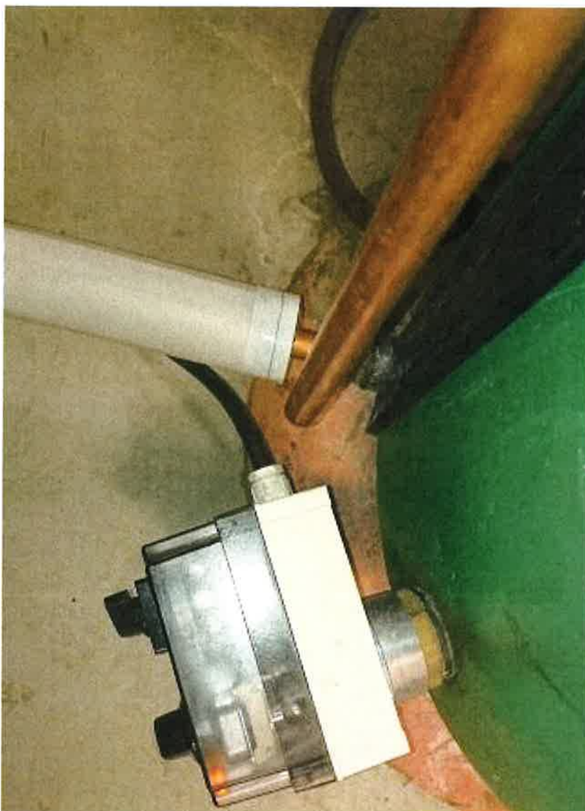
Figur 14. Säkerhetsventil mynnar ut på elpatron
