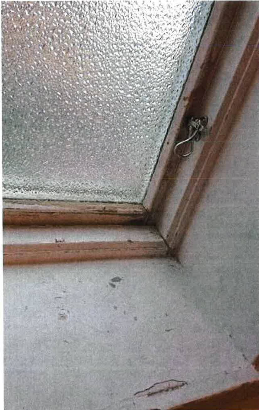
Figur 9. Fönster i duschutrymme
