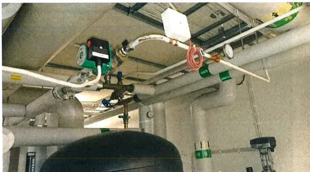
Figur 13. Oisolerade rör vid VVC pump
