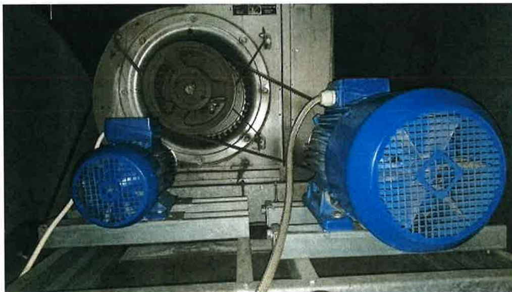
Figur 15. Fläktar i TA2, remdrivna och med framåtböjda skovlar
