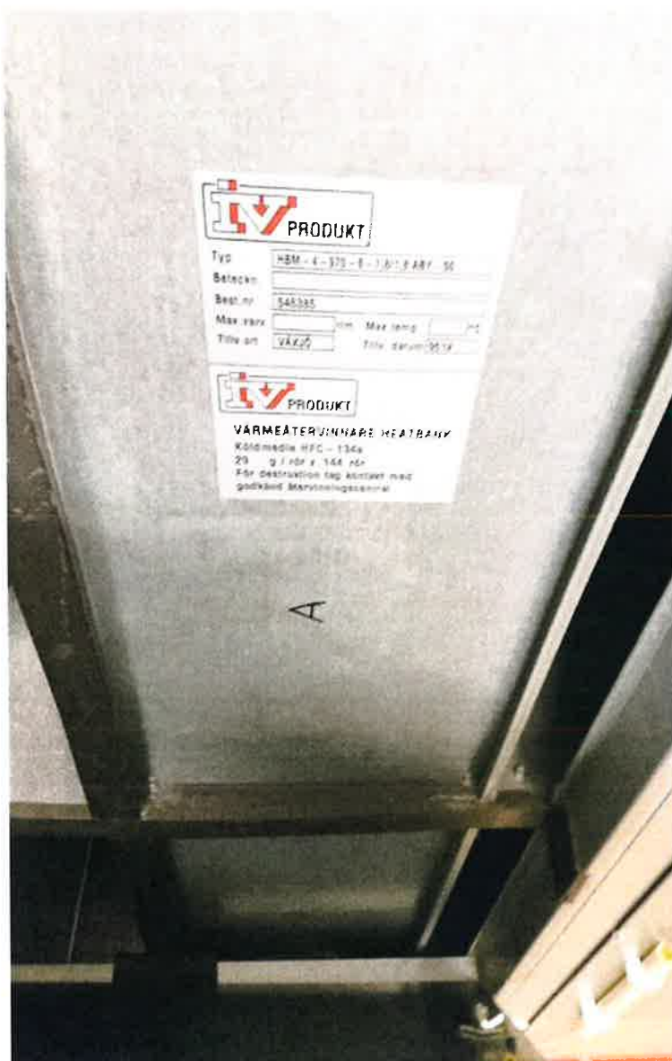
Figur 8. Återvinningsmodul av typen Heatpipe
