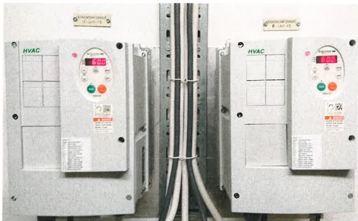
Figur 5. Frekvensomformare LA41
