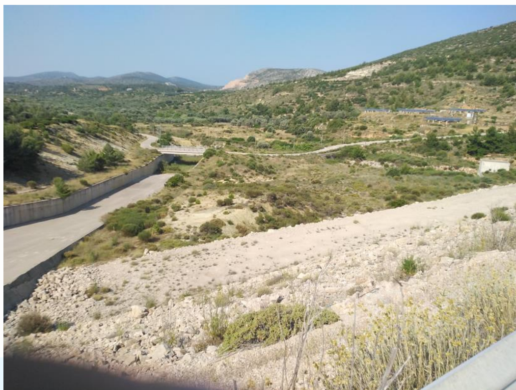
Χίος – Υπερχειλιστής Φράγματος
