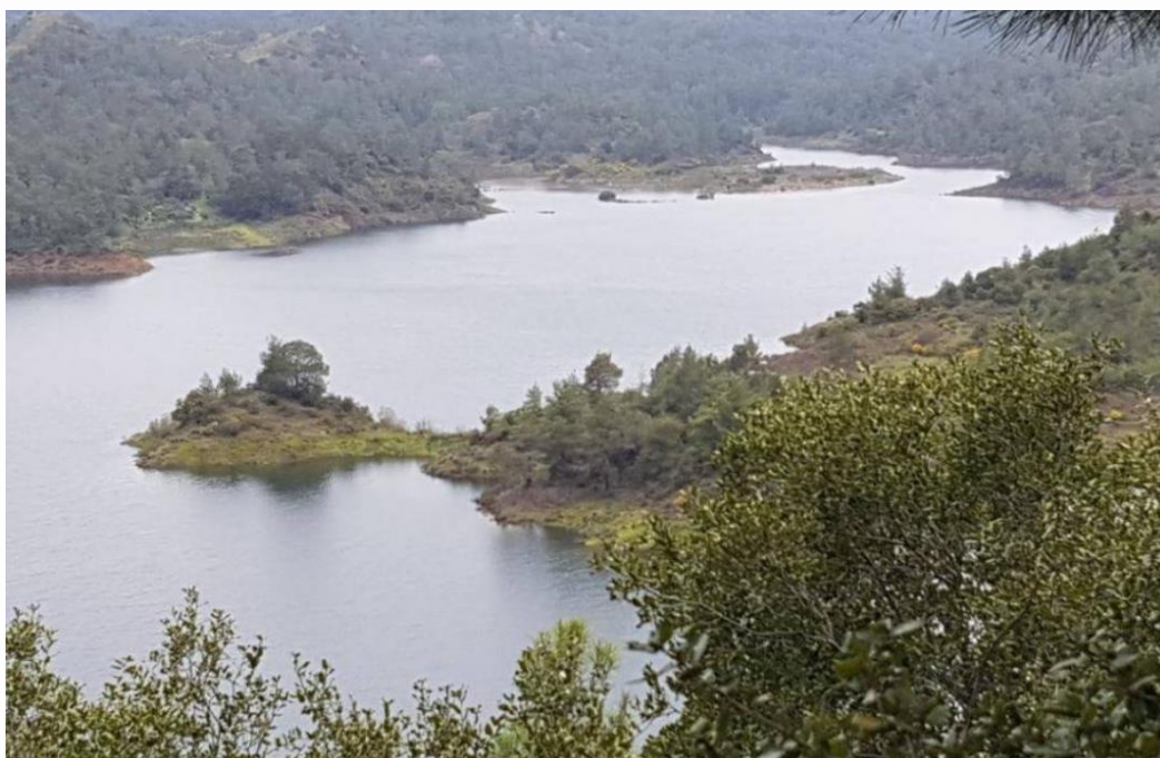
Φράγμα Ευρετού- Κύπρος (φωτογραφία από Θ.Κουνάδης)
