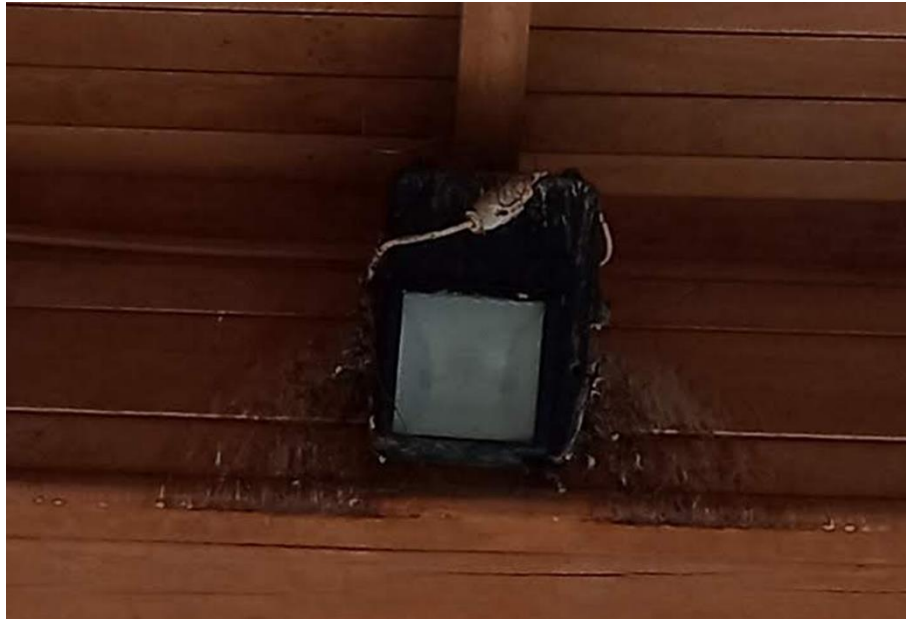
Εικόνα 3β: Προβολέας ιωδίνης στην κύρια είσοδο του κτηρίου.
