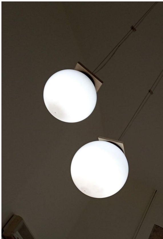
Εικόνα 3γ: Φωτιστικό σώμα «φούσκα» με λαμπτήρες LED στο τμήμα πρωτοκόλλου.
