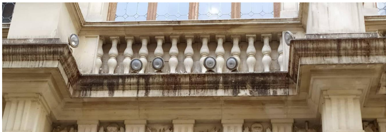
Εικόνα 3α: Προβολείς αλογόνου στο αίθριο του ισογείου του κτηρίου.
