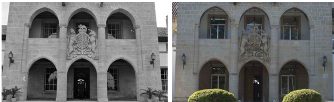
Εικόνα 5: Κτίριο Προεδρικού πριν το πραξικόπημα του 1974 και μετά την αποκατάσταση 22
