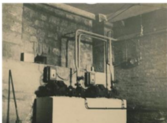
Εικόνα 4: Δεξιά πάνω: Σύστημα παροχής ζεστού νερού χρήσης με καύση άνθρακα. Δεξιά κάτω: Ηλεκτρικές αντλίες νερού. Αριστερά: Ηλεκτρική εγκατάσταση
