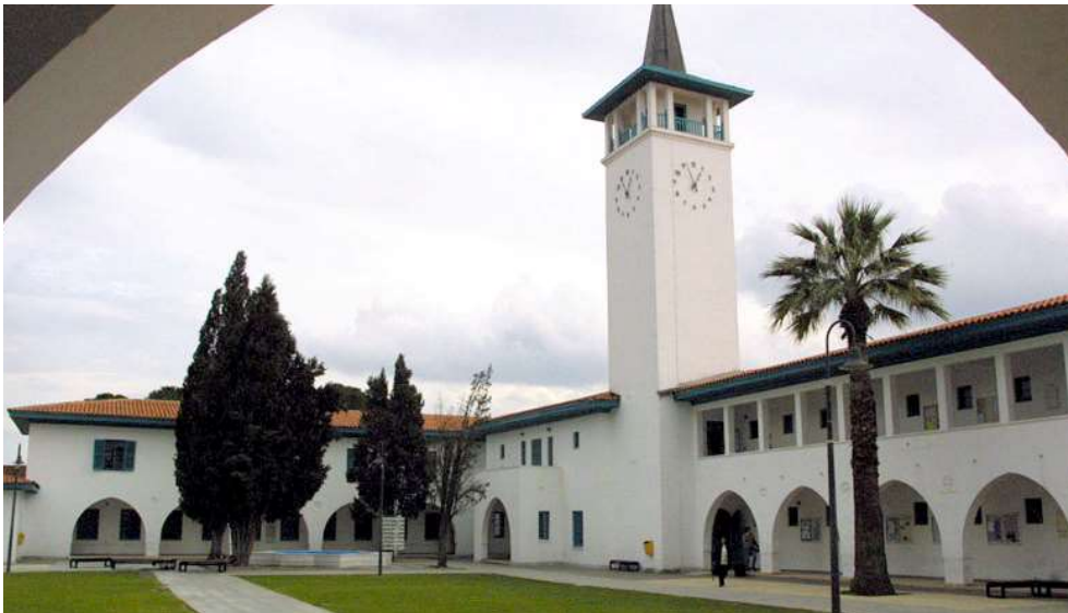
Εικόνα 24: Φωτογραφία της κύριας αυλής του συγκροτήματος σε σύγχρονη εποχή αλλά πριν από τις τελευταίες εργασίες αποκατάστασης. Πηγή: https://smapse.com
