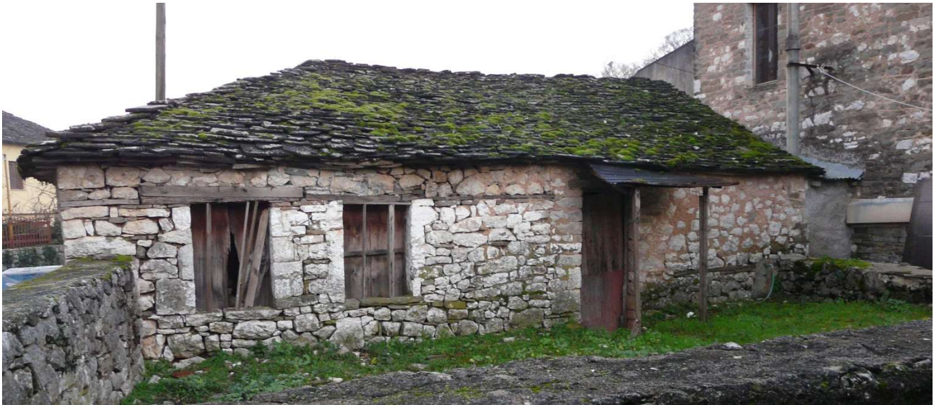
Εικόνα 3. Παραδοσιακό λιθόκτιστο κτίσμα στο διατηρητέο οικισμό του Νησιού Ιωαννίνων, το οποίο βρίσκεται στη λίμνη Παμβώτιδα, στην Ελλάδα. Φωτογραφία Ειρήνη Κυρίτση
