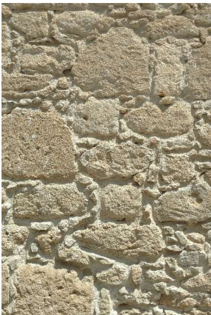
Εικόνα 20. Περιπτώσεις παραδοσιακών τοιχοποιιών: αριστερά αργολιθοδομή από τοπικό πωρόλιθο, κέντρο αργολιθοδομή από σκληρή ηφαιστειογενή πέτρα και δεξιά ωμπλινθοδομή.
