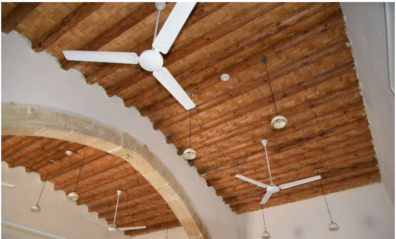
Εικόνα 17. Παλιό μπακάλικο Αγλαντζιάς, Τοποθέτηση ανεμιστήρων οροφής, πρόγραμμα "HYBUILD", Φωτογραφία: Βαϊά Ροπόκη
