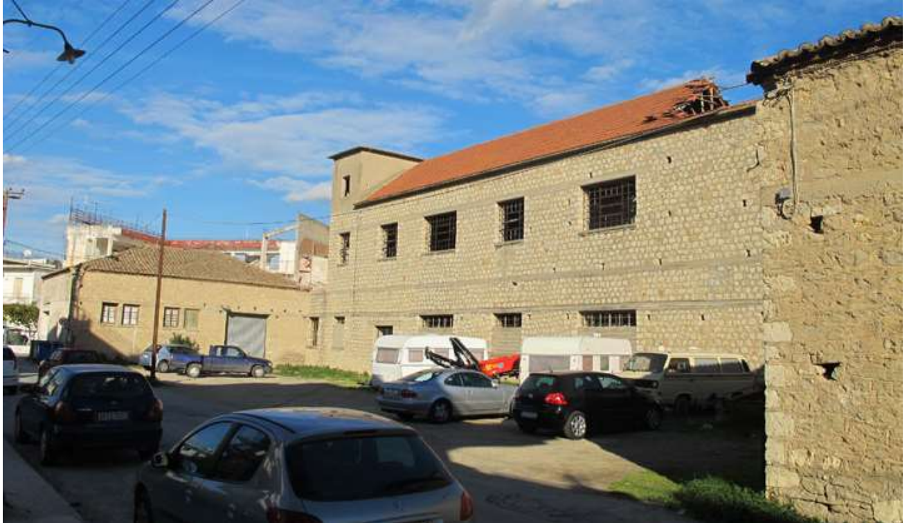
Εικόνα 30: Το βιομηχανικό κτίριο πριν την αποκατάσταση. Πηγή: περιοδικό Building Green https://www.buildinggreen.com/
