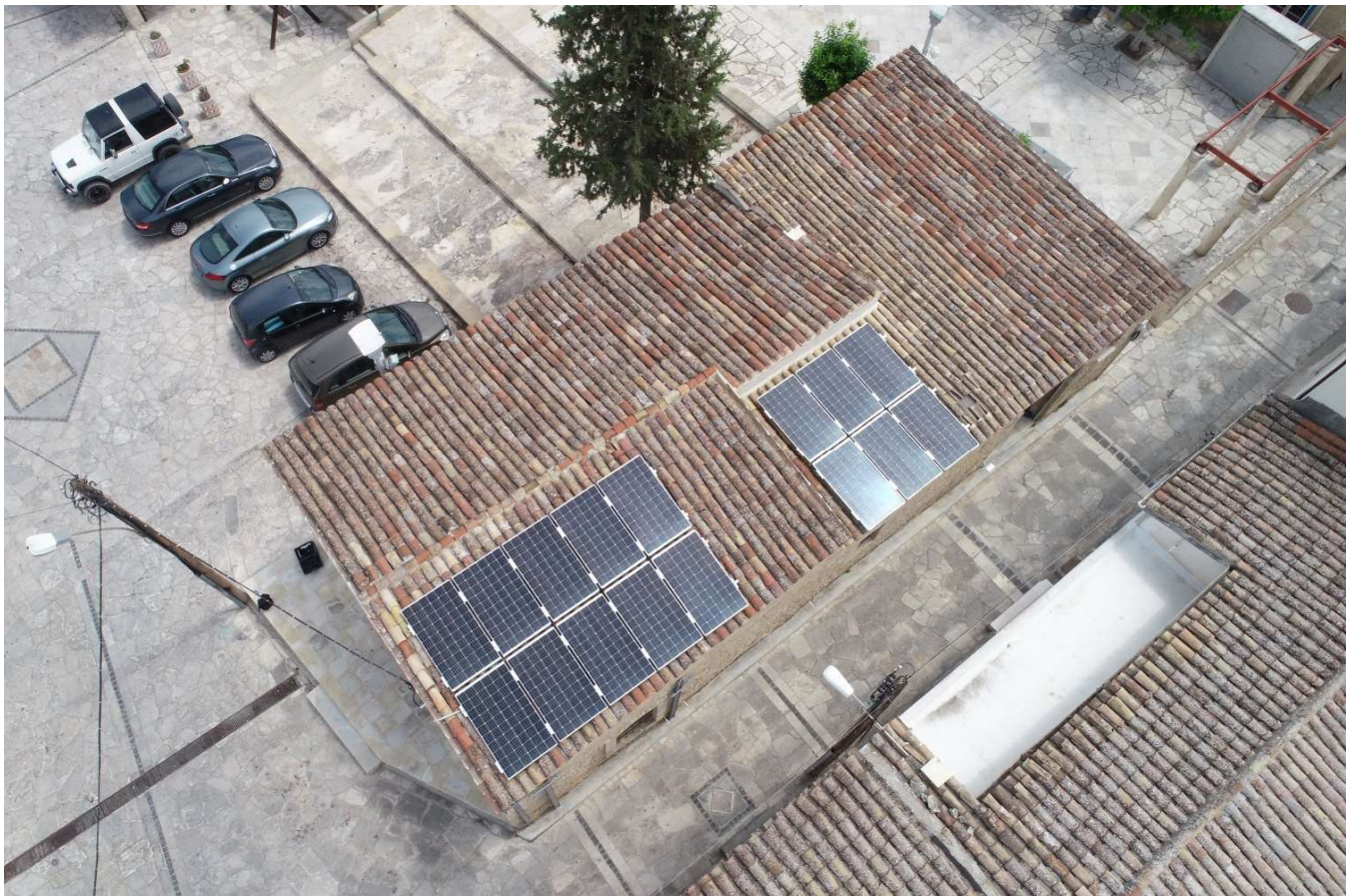
Εικόνα 19. Τοποθέτηση φωτοβολταϊκών πανέλων σε διατηρητέο κτίριο. Φωτογραφία: Γιώργος Βεσιάρης
