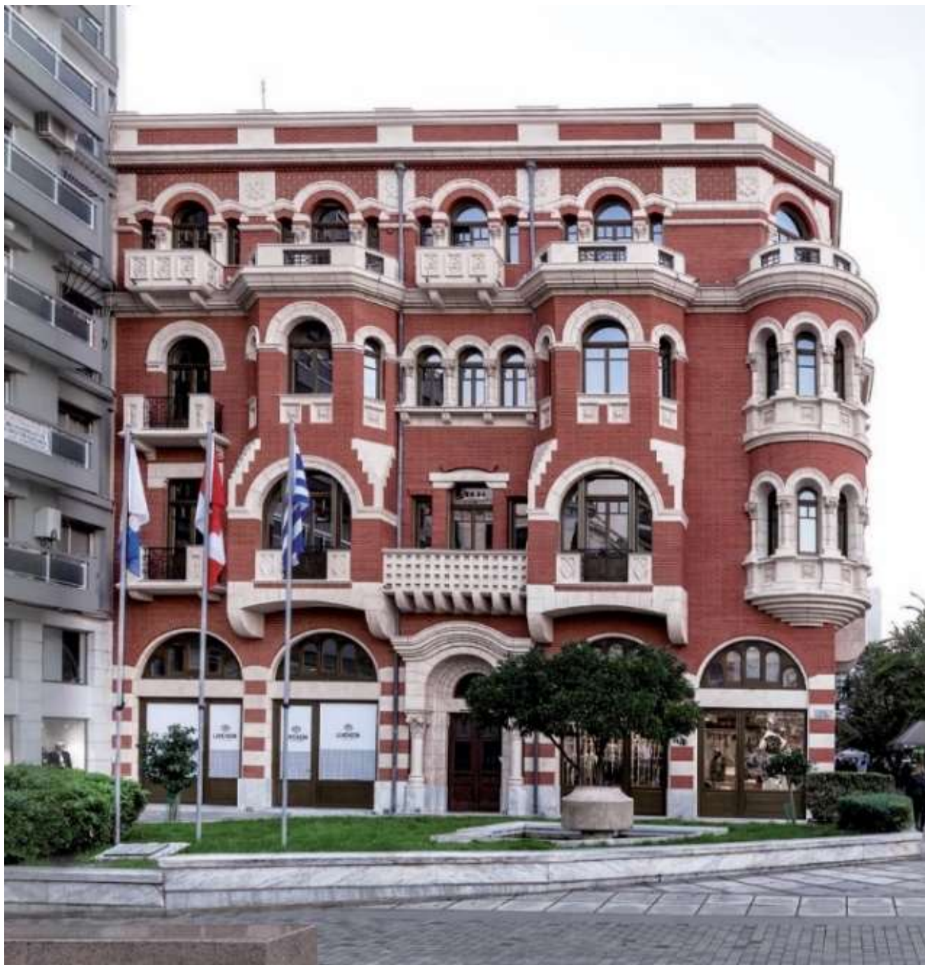
Εικόνα 33: Εξωτερική όψη κτιρίου μετά τις εργασίες αποκατάστασης. Πηγή: περιοδικό Κτίριο https://ktirio.gr/
