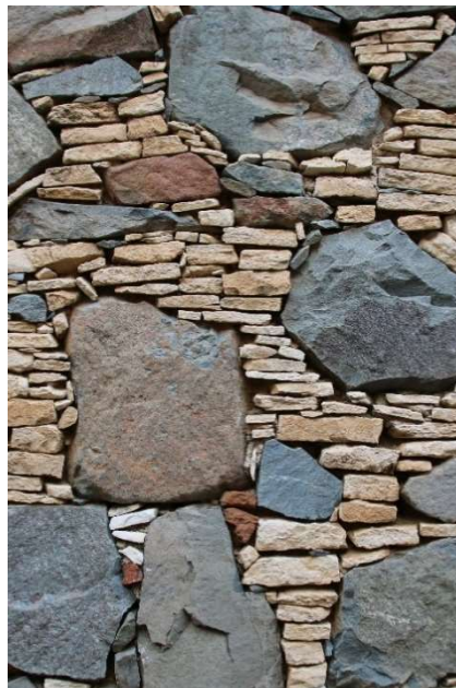
Εικόνα 20. Περιπτώσεις παραδοσιακών τοιχοποιιών: αριστερά αργολιθοδομή από τοπικό πωρόλιθο, κέντρο αργολιθοδομή από σκληρή ηφαιστειογενή πέτρα και δεξιά ωμπλινθοδομή.
