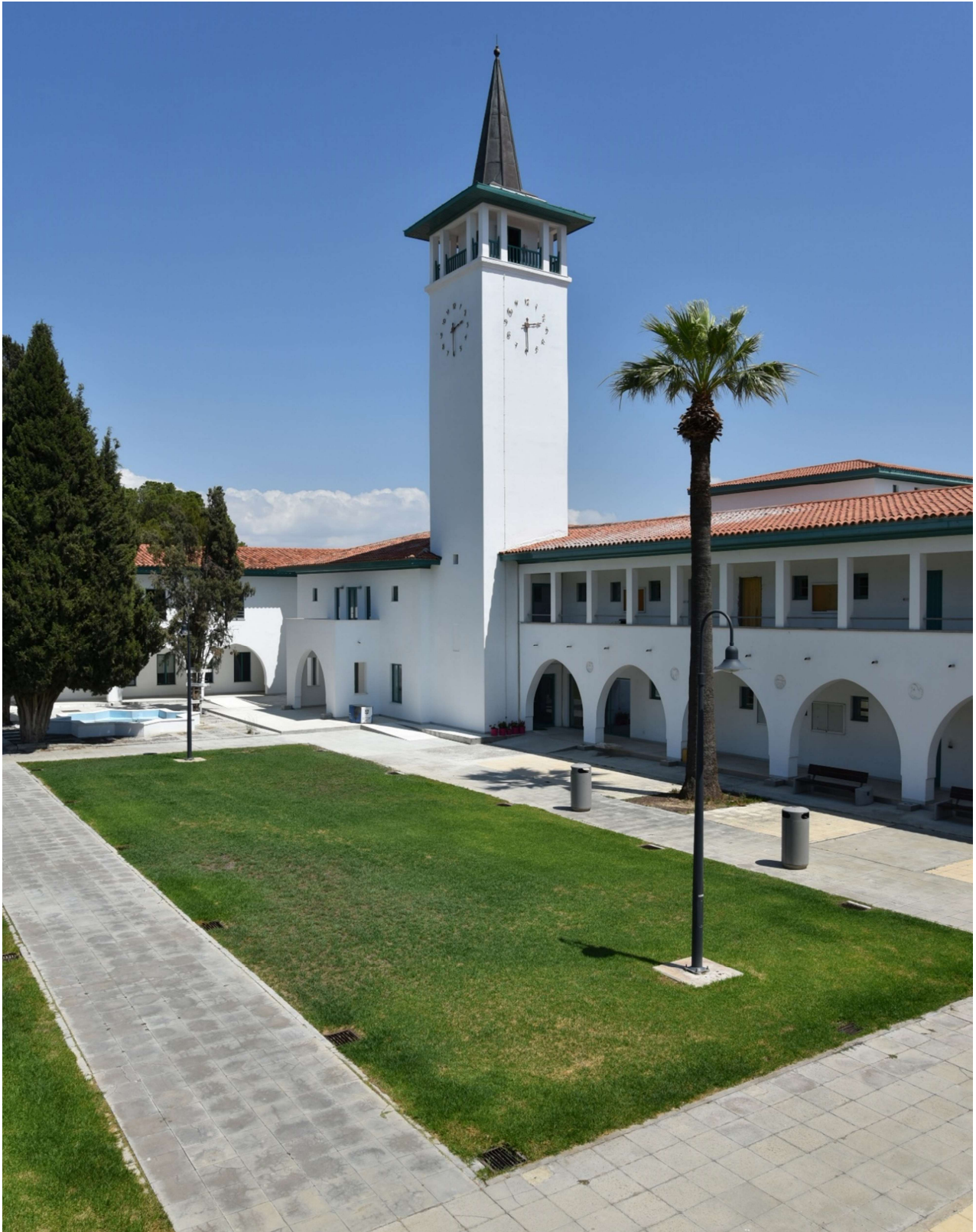
Εικόνα 8. Η κύρια αυλή του ιστορικού κτιρίου της Παιδαγωγικής Ακαδημίας, η οποία δέχτηκε εργασίες ενεργειακής αποκατάστασης από το 2016 μέχρι 2021 και στεγάζει τμήματα του Πανεπιστημίου Κύπρου. Φωτογραφία Ειρήνη Κυρίτση
