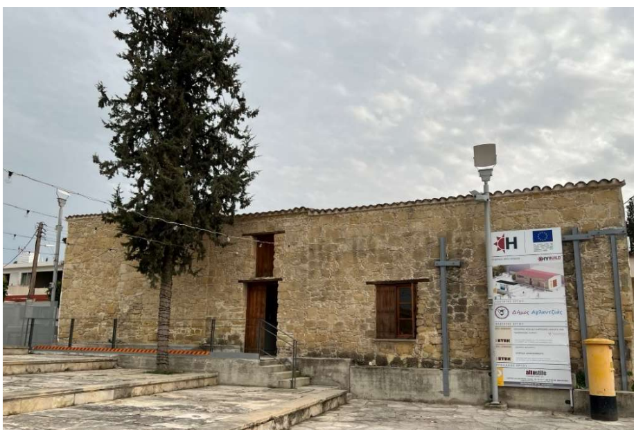
Εικόνα 9. Πρώην «Παραδοσιακό μπακάλικο Αγλαντζιάς», το οποίο δέχτηκε εργασίες ενεργειακής αποκατάστασης στο πλαίσιο του ερευνητικού προγράμματος "HYBUILD", από το 2017 μέχρι 2021.
