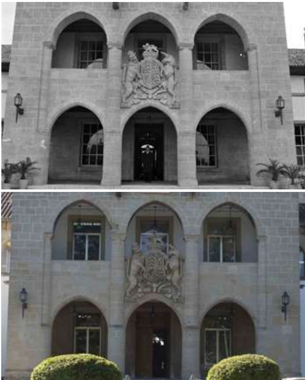
Εικόνα 5: Κτίριο Προεδρικού πριν το πραξικόπημα του 1974 και μετά την αποκατάσταση 7
