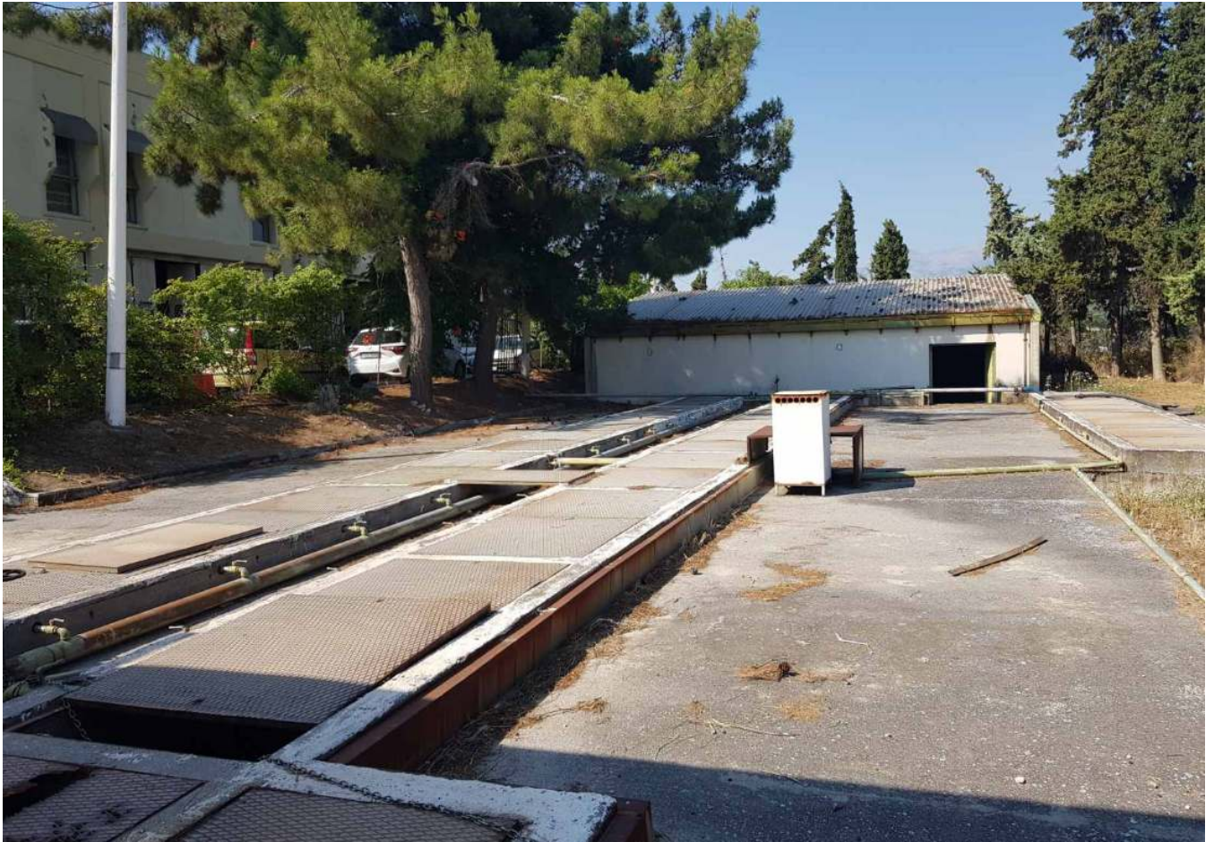
Εικόνα 02: Υπάρχουσα συμβατική εγκατάσταση επεξεργασίας υγρών αποβλήτων ΠΑΓΝΗ
