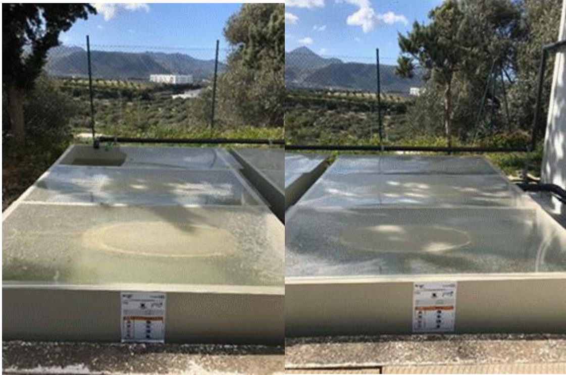
Εικόνα 33: Εικόνα : Δεξαμενές/Λεκάνες Μονάδας μετεπεξεργασίας με φυτά Lemna minor.
