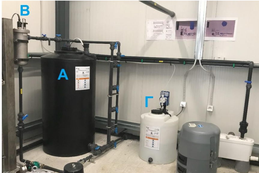
Εικόνα 44: Μονάδα απολύμανσης με τεχνολογία προηγμένης οξείδωσης.
