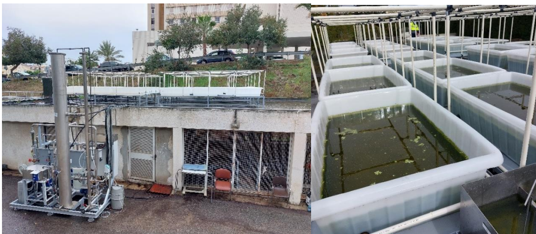
Εικόνα 1: Το καινοτόμο σύστημα επεξεργασίας νοσοκομειακών λυμάτων κατά το στάδιο δοκιμαστικής λειτουργίας του στο Γενικό Νοσοκομείο Λάρνακας, Κύπρος.
