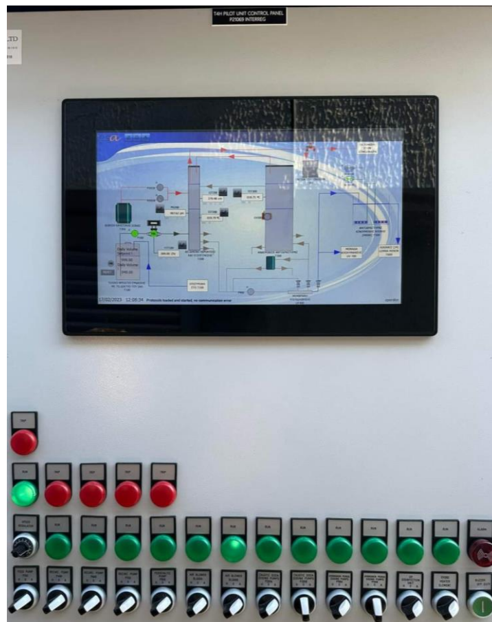
Εικόνα 2-4: Οθόνη LCD μαζί με τους διακόπτες και τις λυχνίες κάθε εξοπλισμού συνδεδεμένα πάνω στο ΚΣΕ
