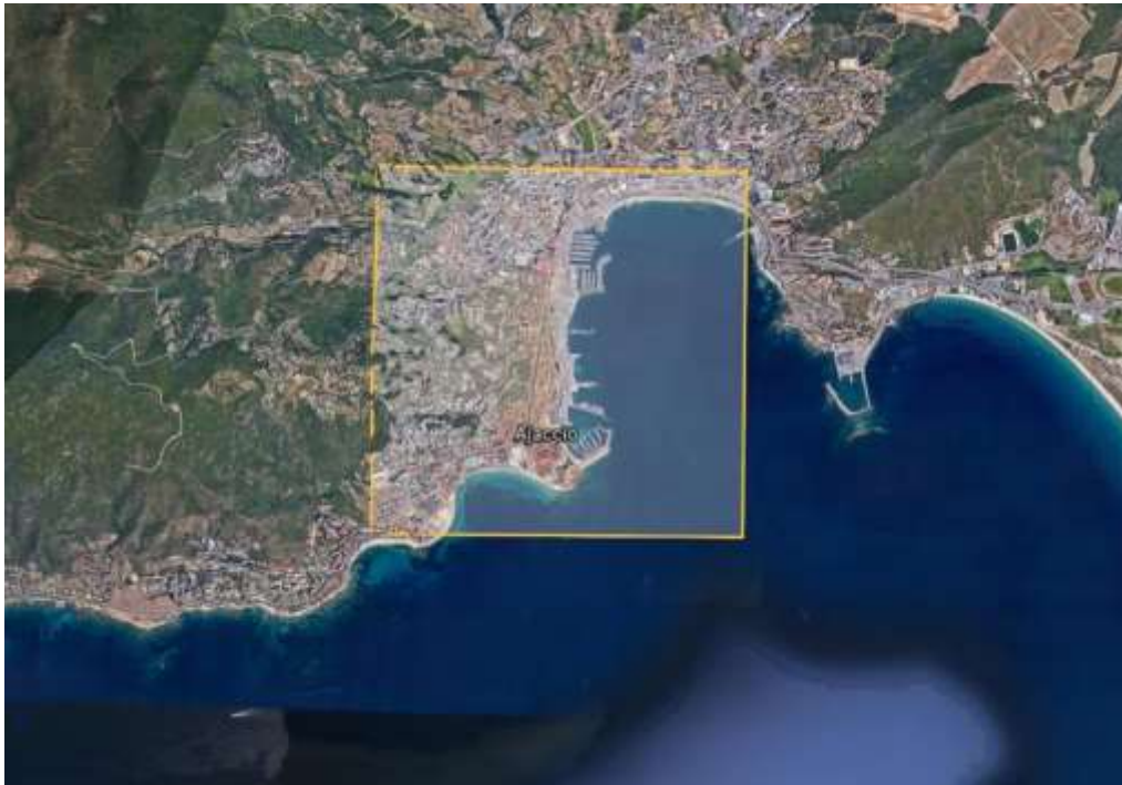
Figure 39. Identification de la zone touchée par le projet portuaire d'Ajaccio.
