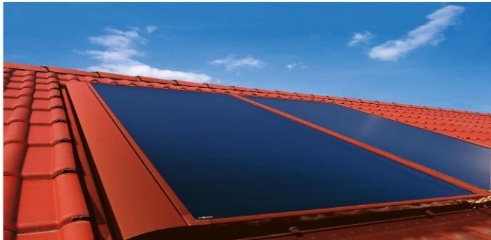
Figuur 67 - Voorbeeld van een thermische vlakplaatcollector (bron: belsolar)
