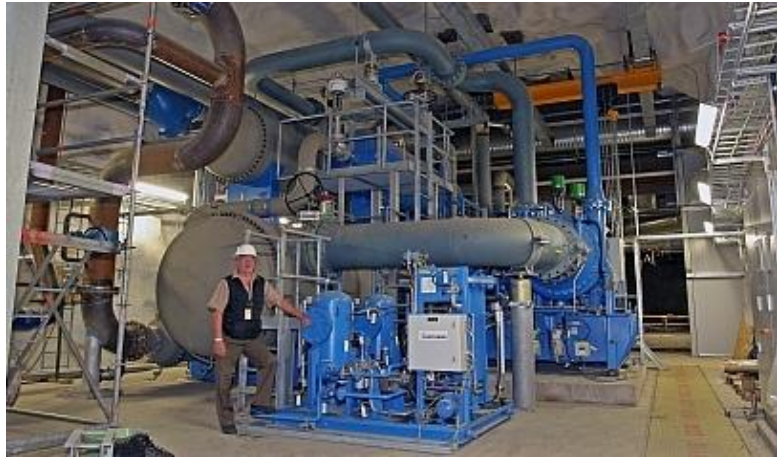
Figuur 63 - Warmtepomp in combinatie met warmtenet te Helsinki (bron: fotograaf onbekend)
