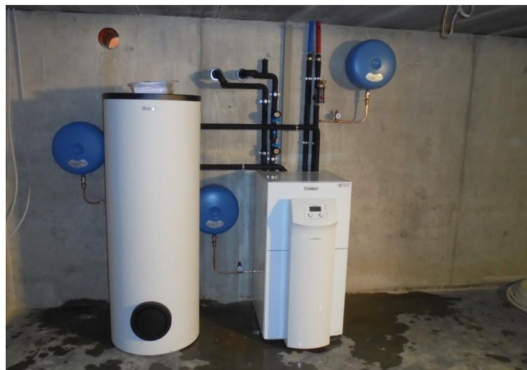
Figuur 66 - Voorbeeld van een residentiële warmtepomp (bron: geoservices.be)
