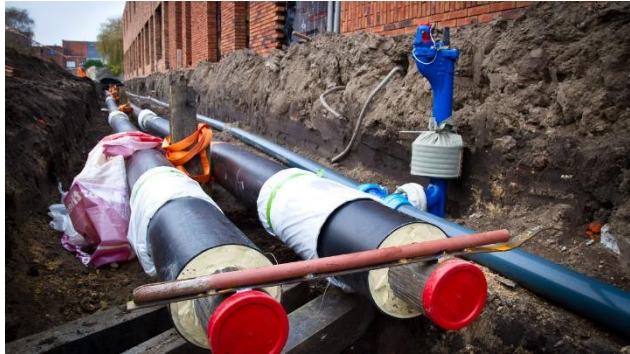
Figuur 62 - Aanleg warmtenet Niefhout fase 1 te Turnhout (bron: SlimTurnhout.Be)
