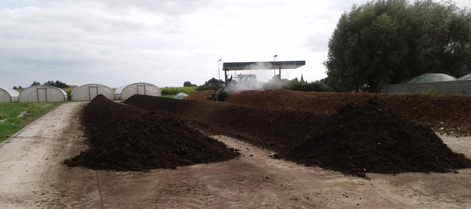
Figuur 8: De composteersite op het ILVO is een mooi voorbeeld van een gunstig ingerichte composteersite. Het betonnen oppervlak is aangelegd onder een lichte helling, waardoor percolaat afwatert richting een opvang. De site is groot genoeg om meerdere rillen naast elkaar aan te leggen met voldoende manoeuvreerruimte.
