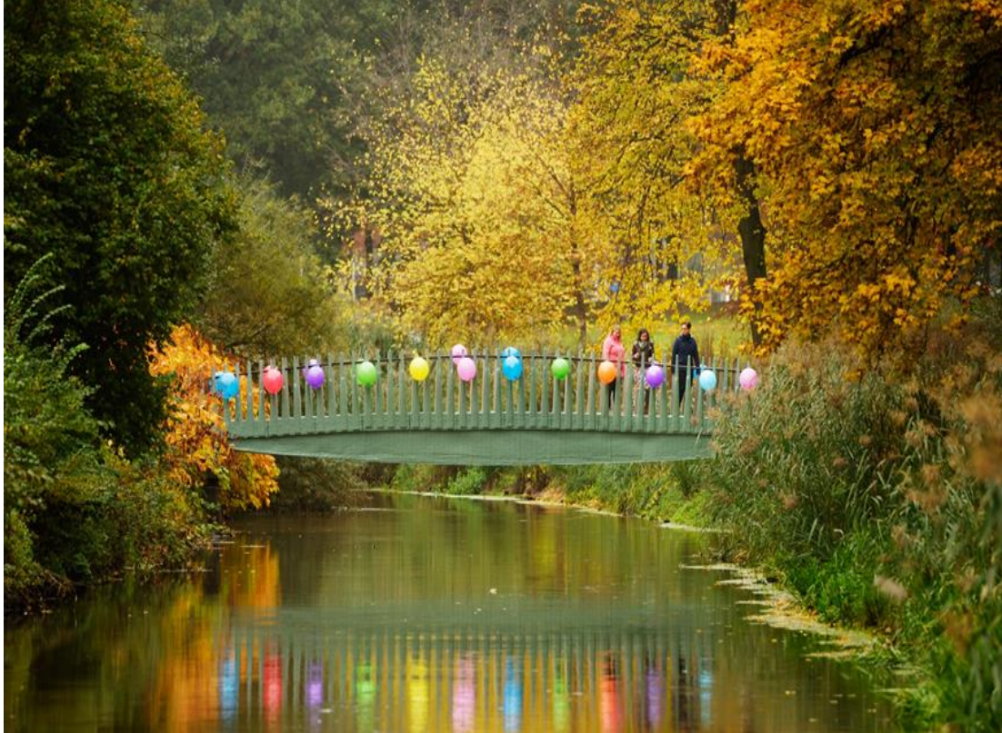
Afbeelding 59 Biocomposietbrug bij de opening in oktober 2016
