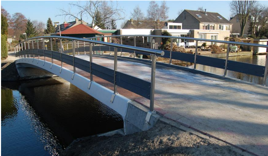
Afbeelding 58 Een op buiging belaste composietbrug Fiets- en voetgangersbruggen in Purmerend gerealiseerd door Fibercore Europe en Haasnoot Bruggen; Bron: www.fibercore-europe.com
