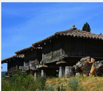
Os espigueiros serviam essencialmente como despensa para o armazenamento de provisões. Apresentam uma planta quadrada, erguida sobre quatro pilares e assentes numa laje. De acordo com o local de construção, podem ter dois, três ou quatro andares. Atualmente existem cerca de 330 espigueiros em León.
