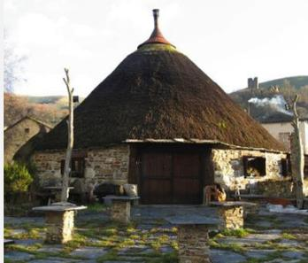
De origem pré-romana, as pallozas (do espanhol) são tradicionais de Ancares e La Cabrera. Caraterizam-se por serem construções de planta oval ou circular, de 10-20 m de diâmetro, paredes baixas de pedra e cobertura à base de material vegetal, geralmente de centeio.
