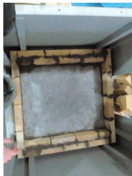
Slika 3 Pri pozidavi smo uporabili ognjevezdržno malto.
