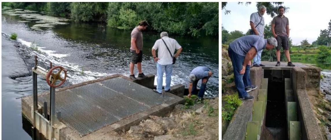
Figura 6. Escala de tipo Denil fuera de uso en la localidad de Pontearnelas, río Umia.
