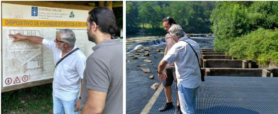
Figura 5. Visita al coto de pesca de Couso (río Ulla), en cuyo límite superior se instaló una escala de peces de hendiduras verticales y un paso “naturalizado”.
