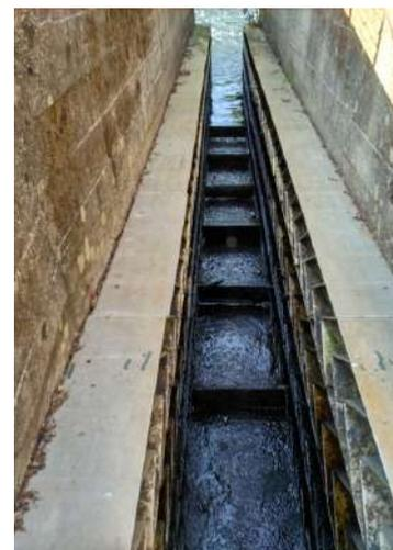
Figura 4. Visita al capturadero de Ximonde (río Ulla), gestionado por la Xunta de Galicia y dotado con una escala de artesas y una escala de deflectores laterales.
