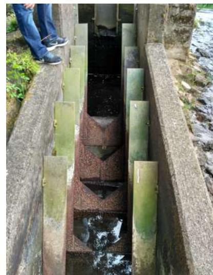
La efectividad de las escalas de peces depende de una gran variedad de factores como: las especies presentes en el sistema, su comportamiento y capacidad natatoria (tamaño, condición, etc.); las condiciones hidráulicas, tales como turbulencia y velocidad de corriente, tanto en la escala como en las inmediaciones de la entrada a la misma (determinantes en la atracción de los peces), dimensiones y características de la estructura, posición y orientación, etc.
