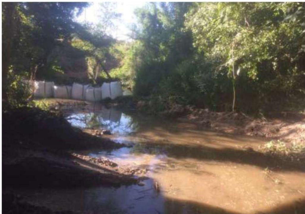
Desvío provisional mediante la ejecución de ataguías de sacos para secar el ramal derecho del río.
