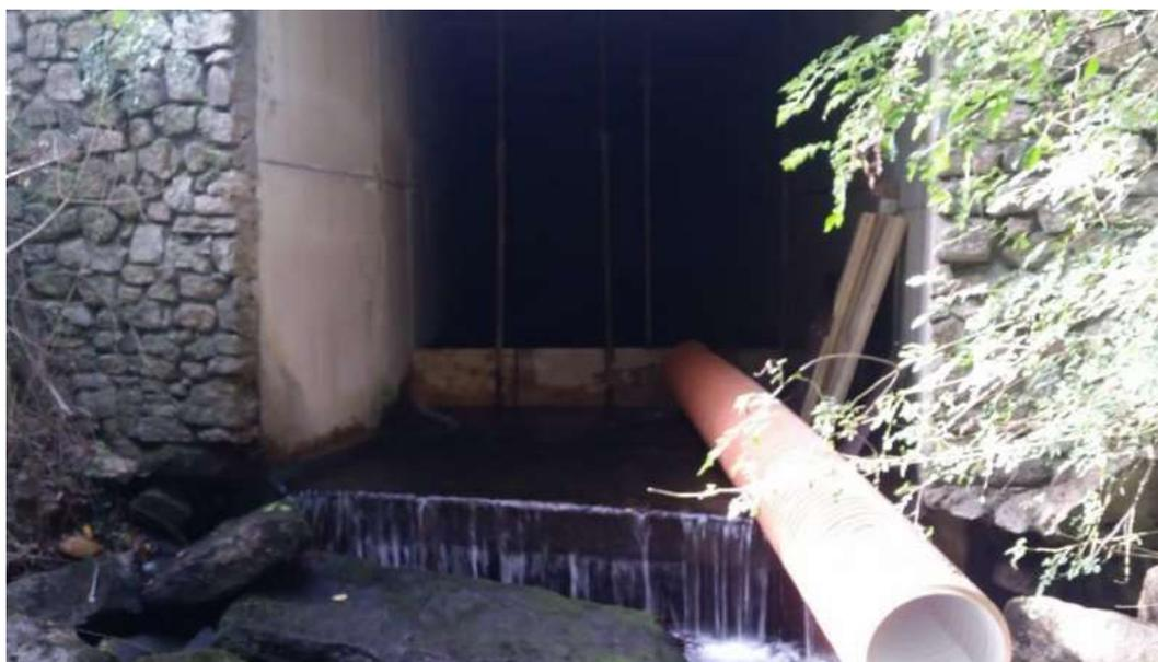
Posición del desvío del caudal circulante para poder ejecutar la escala de peces.
