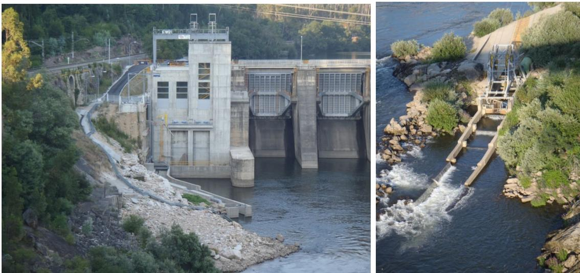
Figura 15. Dispositivos de franqueo presentes en la presa, ascensor y escala de anguilas (a la izquierda) y teleférico inutilizado (a la derecha).
