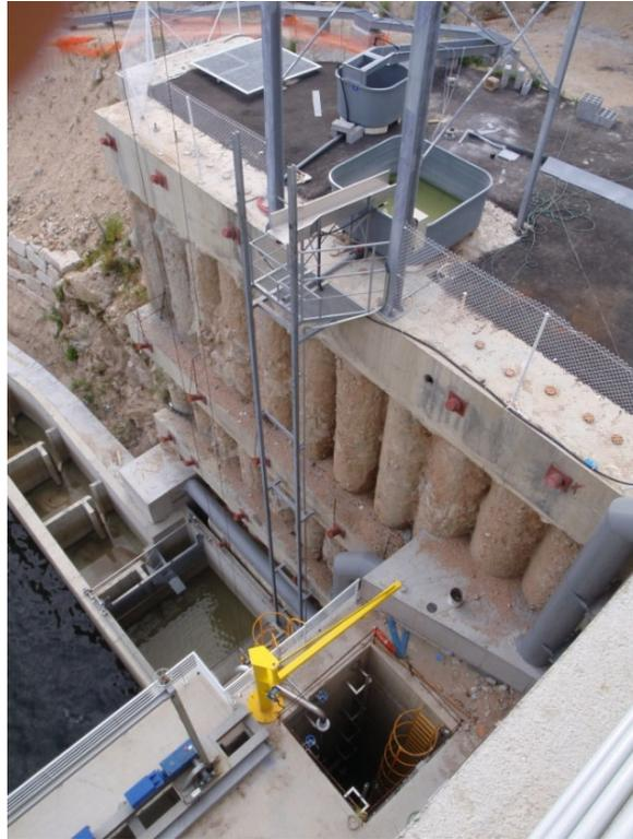
Figura 14. Escala de hendiduras verticales y ascensor situado en la margen derecha de la presa de Frieira.
