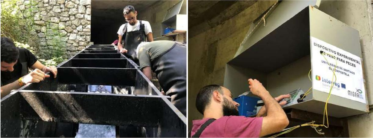
Figura 24. Instalación de las antenas en la escala modular del río Caselas.
