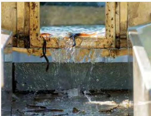
La captura de angulones se realiza por una escala de peces que gracias a un elevador permite transportar los ejemplares para su manipulación
